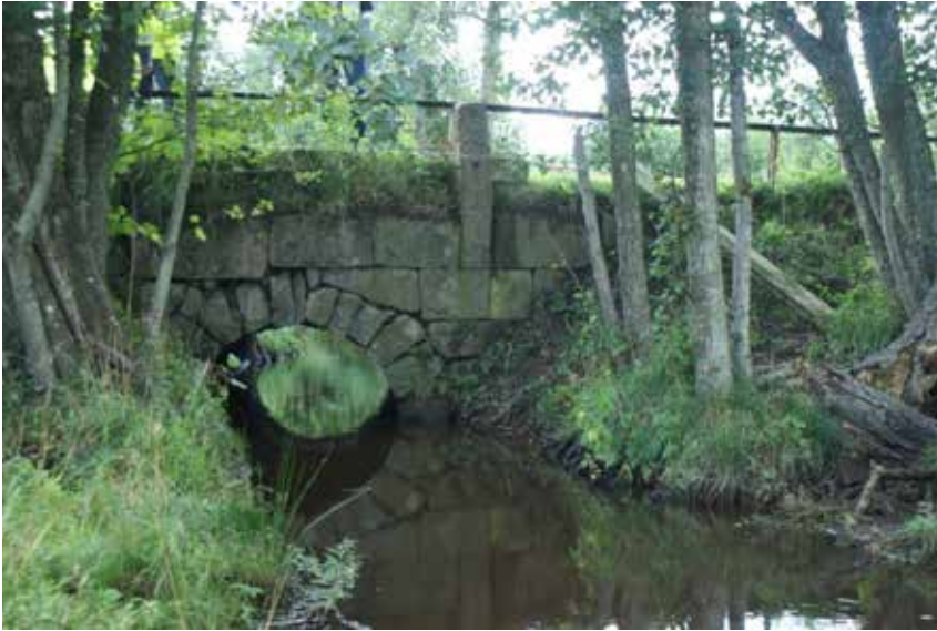
4.5:15. Stenvalvsbron som leder över Märskabäcken, Skånings-Åsaka 87:1. Vägen som leder över bron är en föregångare till E20, strax väster om nuvarande väg.
