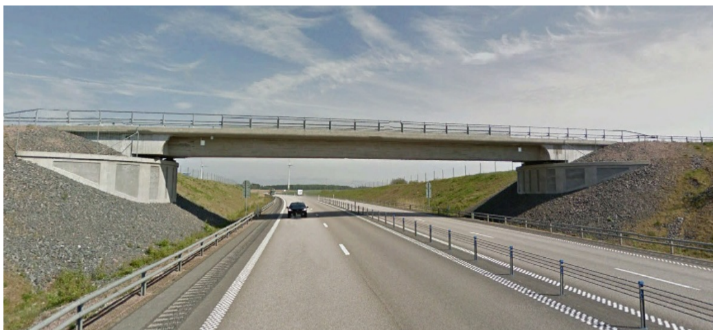
Den befintliga bron vid Ledsjö, av typen plattramsbro.
