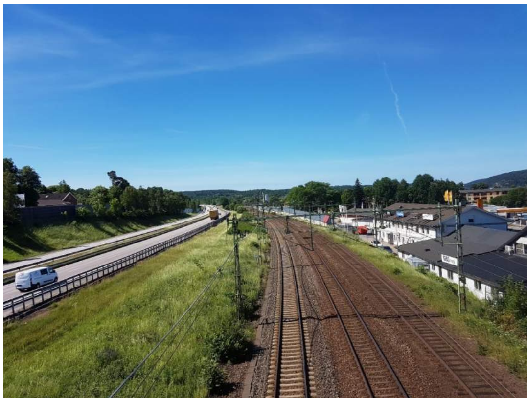
Figur 8. Bild tagen från Stationsvägens vägbro och västerut, ca km 437+950 (COWI 2018).
