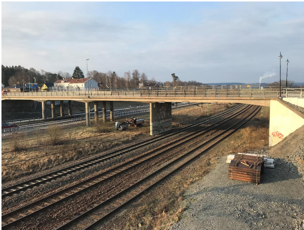
Figur 23 Befintliga spår under Stationsvägens vägbro
