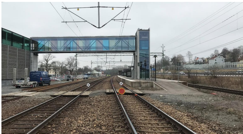
Figur 8 Stationsområdet i Lerum sett åt nordost. Gångbro mellan parkeringshus och mittplattform närmast i bild.
