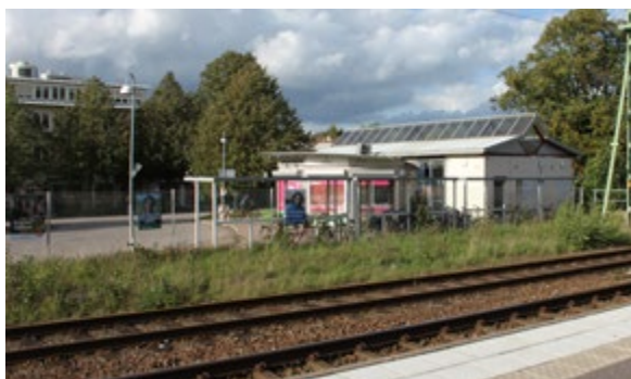
Figur 53 Stationsbyggnaden, vy från mittplattform.
