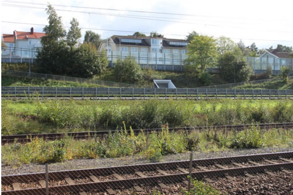
Figur 78 Vy från mittplattform mot villaområde i söder. Även gångtunnelns anslutning syns i bilden.
