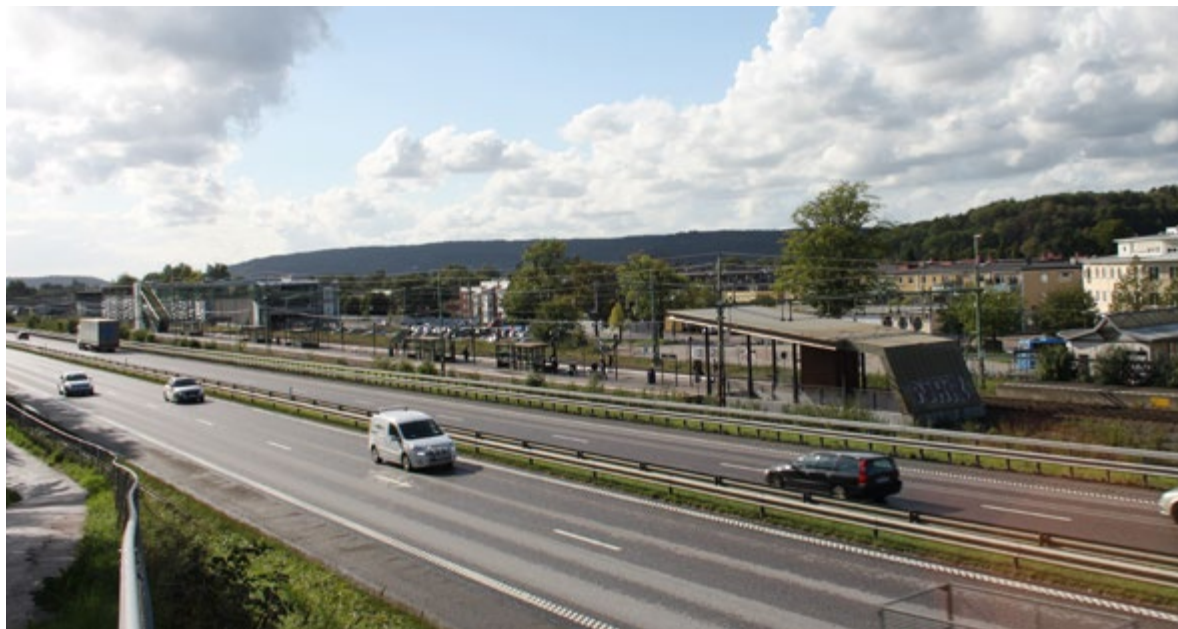
Figur 46 Storskaligt infrastrukturrum med väg E20 och Västra stambanan.
