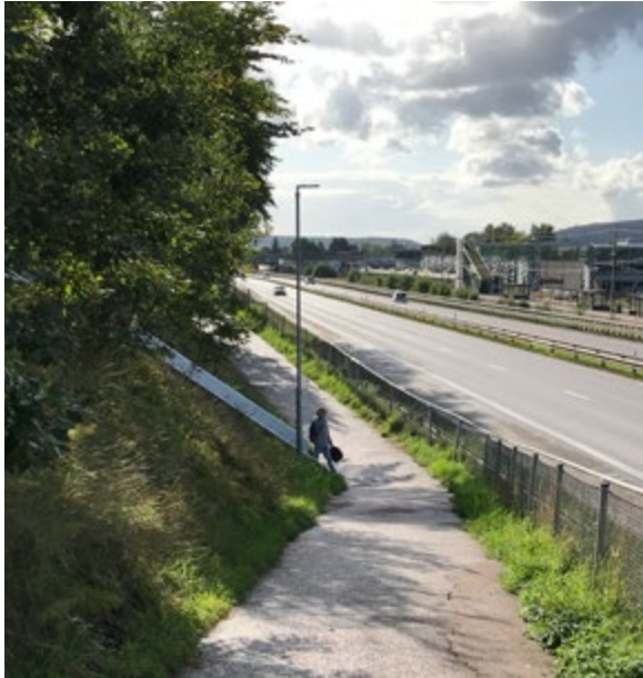
Figur 21 Södra anslutningen till gångtunneln med anslutande gångbana.
