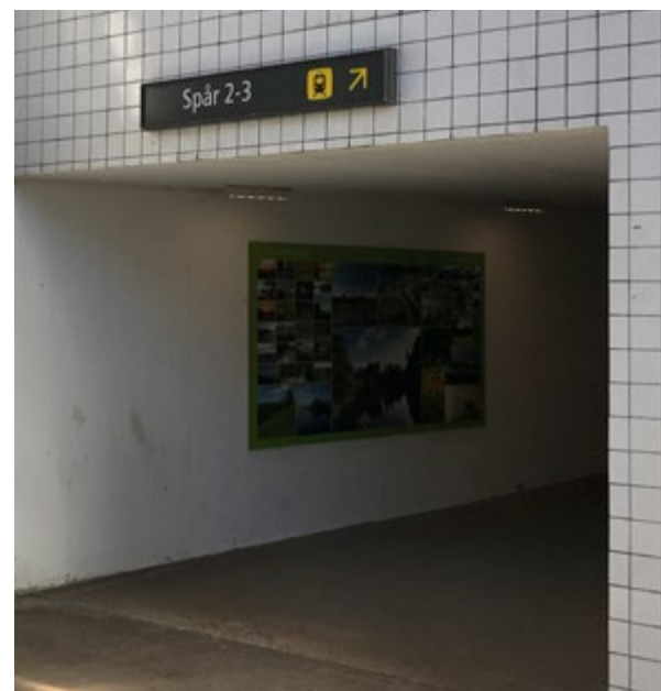
Figur 15 Skyltning i gångtunnel till mittplattform.
