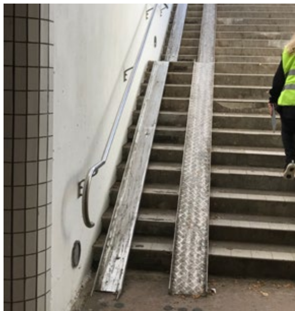
Figur 18 Barnvagnsramp vid norra anslutningen.
