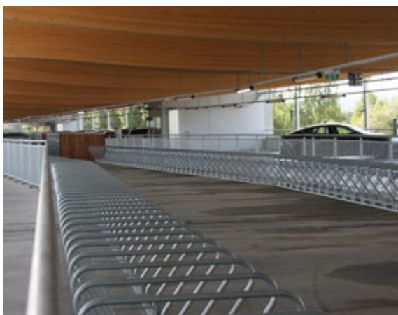
Figur 28 Cykelparkering i parkeringshuset.
