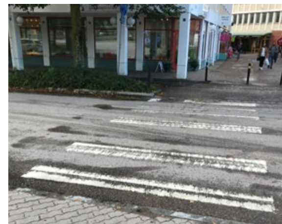
Figur 33 Passage över Stationsvägen för oskyddade trafikanter, i höjd med gångtunnel. Passagen är inte tillgänglighetsanpassad.
