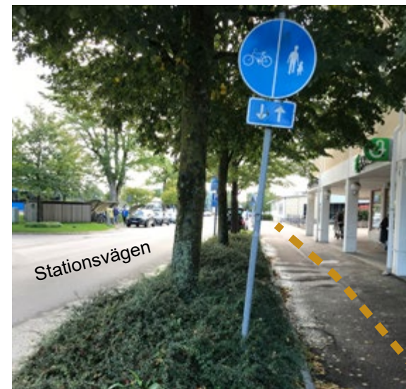
Figur 32 Gång- och cykelbana norr om Stationsvägen.
