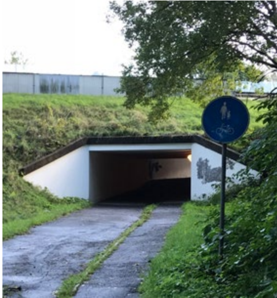
Figur 22 Tunnel under väg E20 vid passagen intill Sävån.
