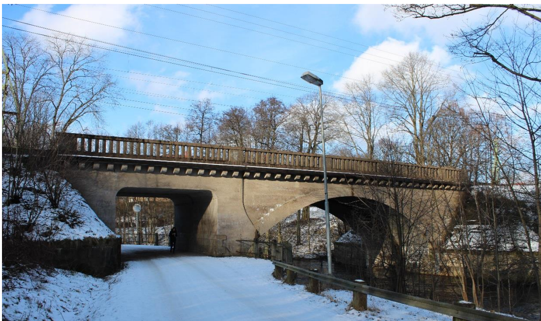
Figur 19. Järnvägsbron över Säveån sedd från söder 2018-02-09. Notera de fina deltaljerna på brons "balk" samt det proportionella balustradliknande broräcket. De båda valven har signifikant olika former. Valvet över ån av mer traditionellt slag och valvet över vägen har en tidstypisk jugendform. Foto författaren.
