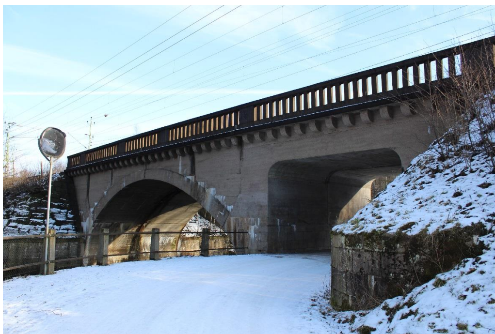
Figur 13. Järnvägsbron sedd från norr 2018-02-09. Foto författaren.
