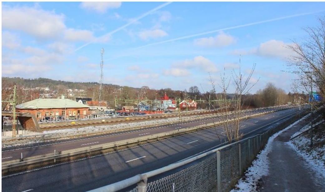
Figur 10. Lerum 2018-02-09. Foto taget från gångtunneln på södra sidan av motorvägen och järnvägen mot stationsbyggnaden och byggnaderna utmed Brobacken. Foto författaren.
