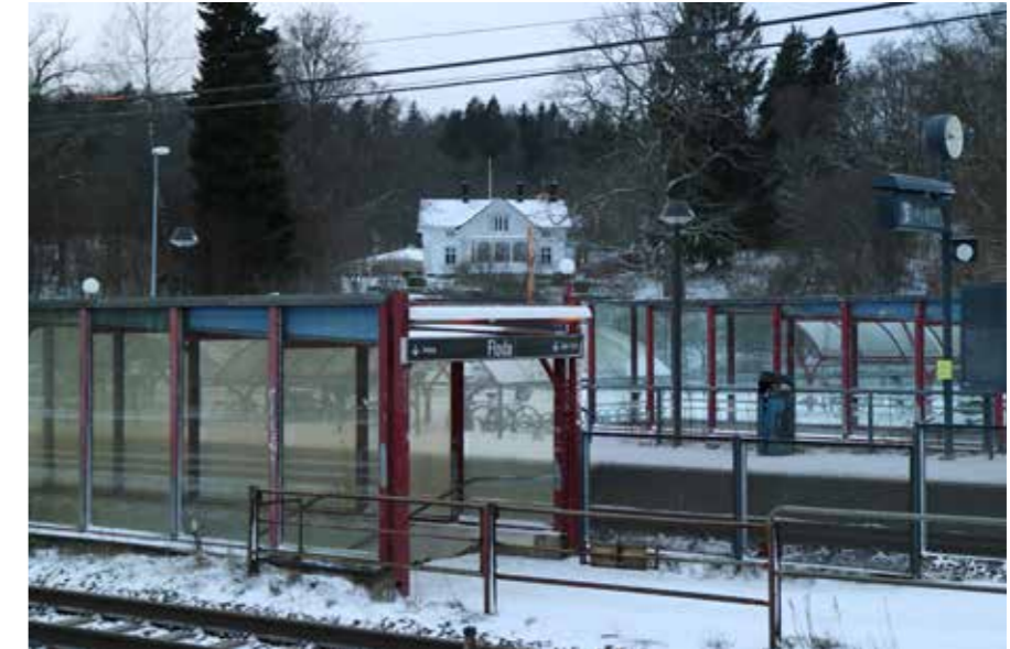
Figur 34 Upp/ nedgång till mittplattform.
