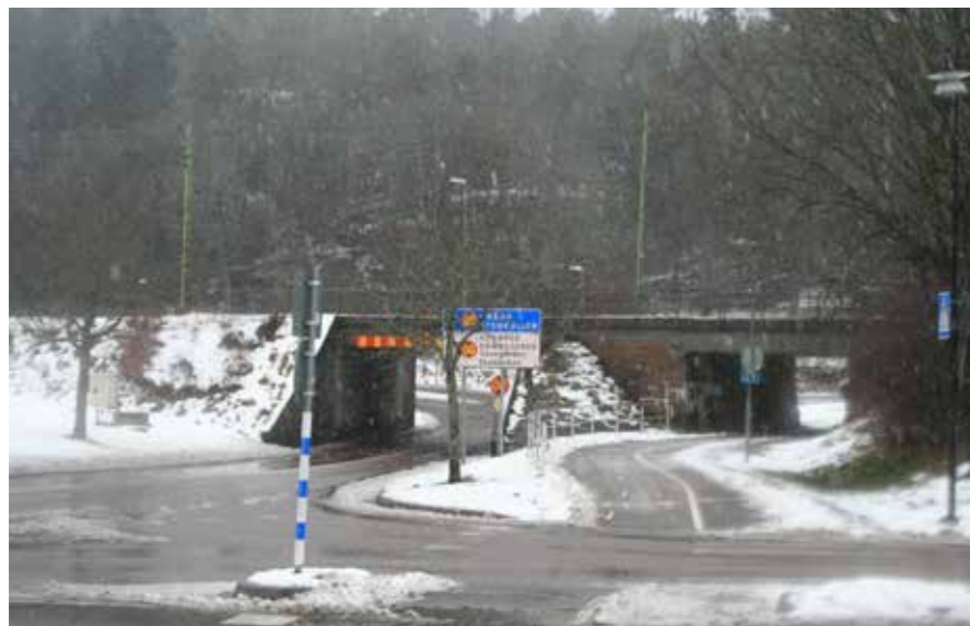
Figur 30 Järnvägsbor över Brovägen med både vägport och gång- och cykelport.
