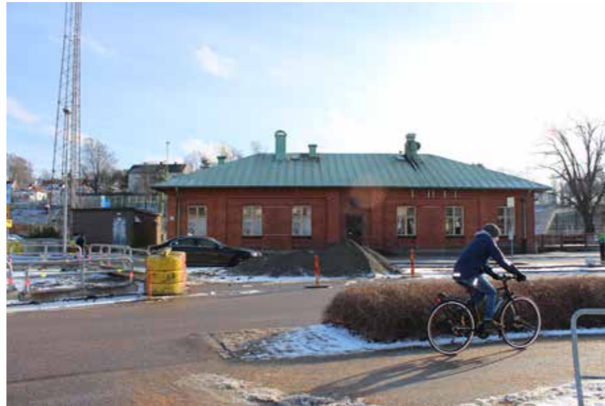
Figur 23 Stationsbyggnaden med initilliggande teknikbyggnad. Foto Västarvet
