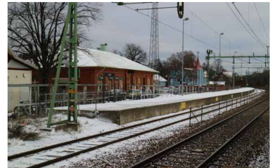
Figur 28 Plattform som nås i markplan från centrumsidan. Stationsbyggnaden syns i bakgrunden..
