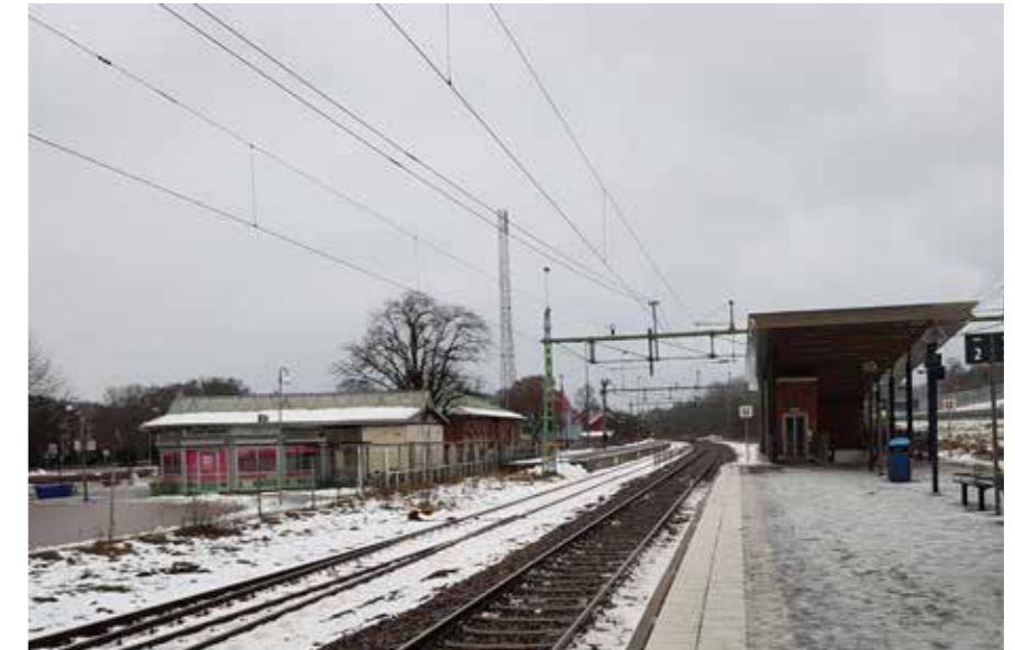
Figur 26 Till vänster i bild byggnad för upp-/nedgång med stationsbyggnaden bakom samt till höger upp-/nedgång till mittplattform
