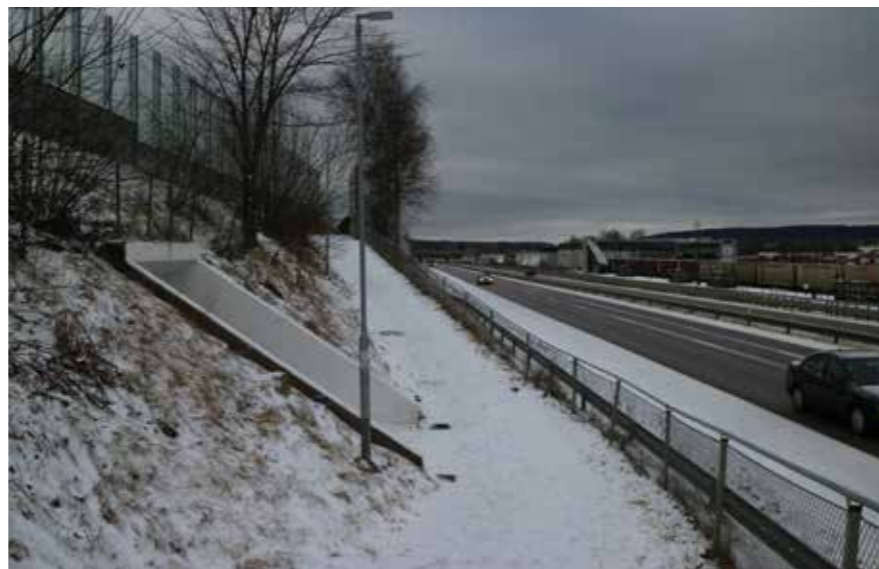
Figur 25 Upp/nedgång till gång- och cykeltunneln som kopplar södra Lerum till stationsområdet.
