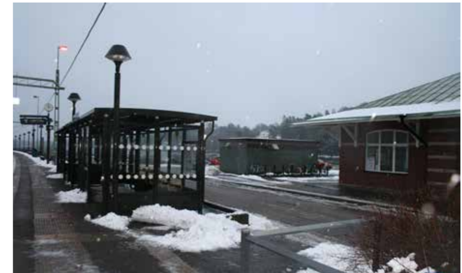
Figur 35 Väderskydd vis sidoplattform samt stationsbyggnaden till höger. I bakgrunden syns en teknikbyggnad.
