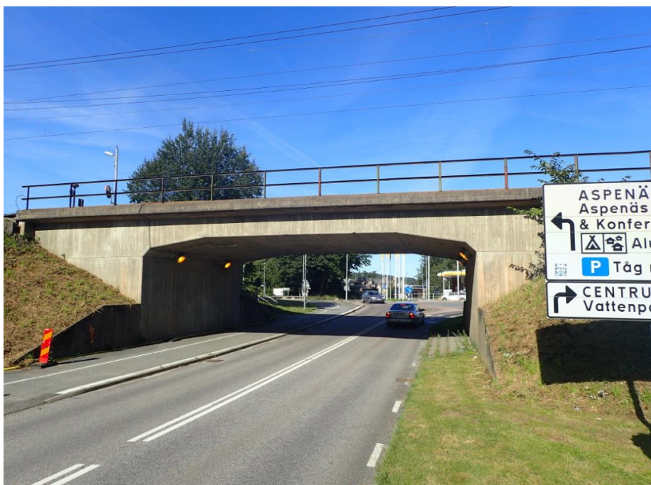
Figur 18 Järnvägsbro över Göteborgsvägen, vy från söder mot norr.
