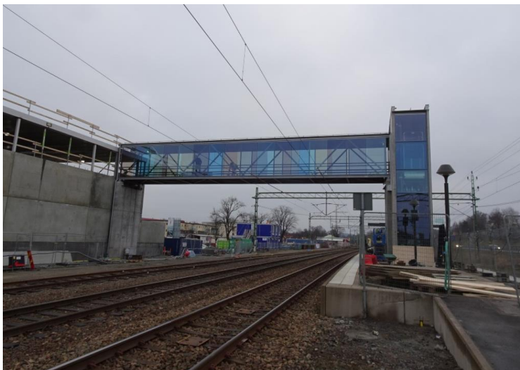
Figur 16 Gångbro mellan parkeringshuset och mittplattform.
