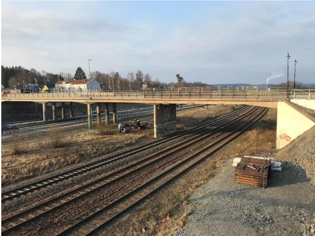
Figur 6 Befintliga spår och väg E20 passerar under Stationsvägens vägbro, bild mot Göteborg.
