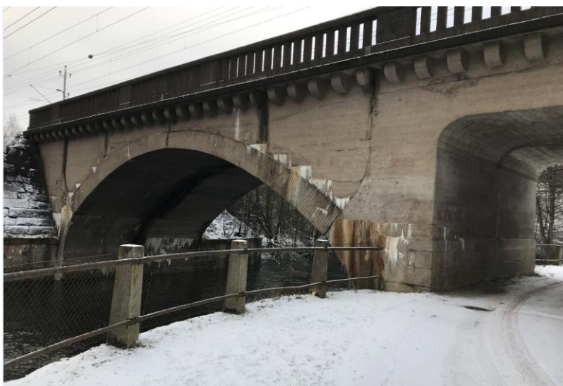
Figur 14 Järnvägsbro över Säveån.
