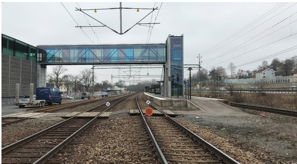
Figur 5 Stationsområdet i Lerum sett från Göteborg. Gångbro mellan parkeringshus och mittplattform närmast i bild.
