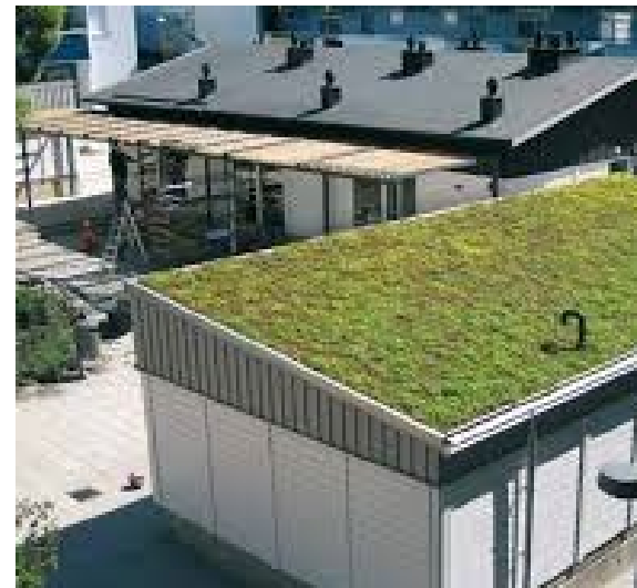
Figur 44 Exempel på sedumtak från Vegtech.
