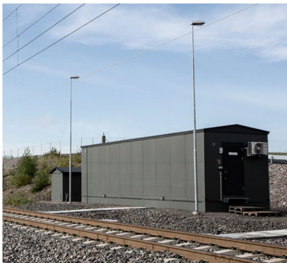
Figur 42 Exempel på teknikbyggnad med betongfasad från Holtab.
