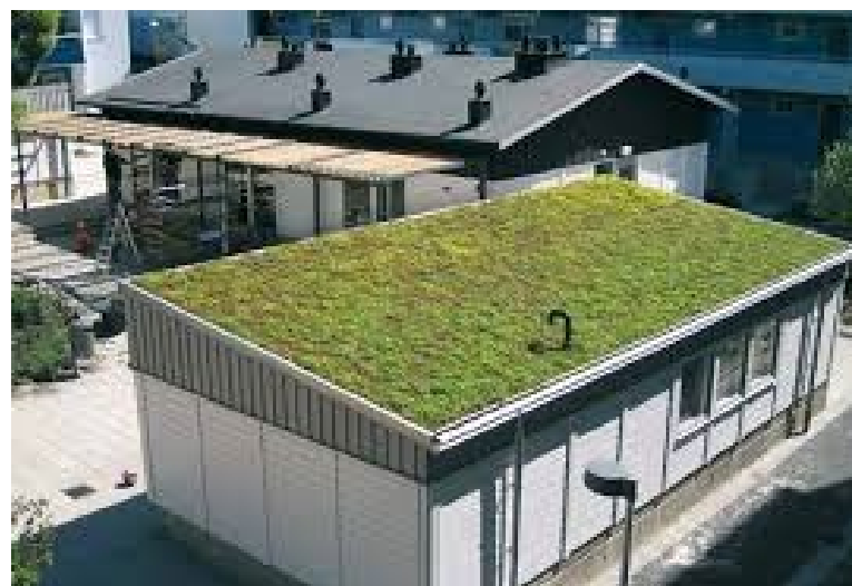
Figur 38 Exempel på sedumtak från Vegtech.
