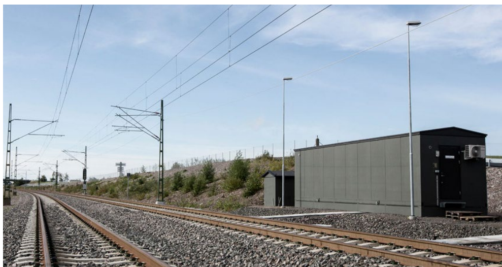
Figur 37 Exempel på teknikbyggnad med betongfasad från Holtab.
