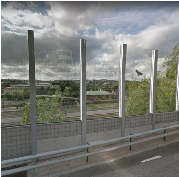
Figur 22 Befintlig bullerskyddsskärm, vy från Södra Långvägen.
