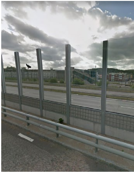
Figur 12 Befintlig bullerskyddsskärm, vy från Södra Långvägen.
