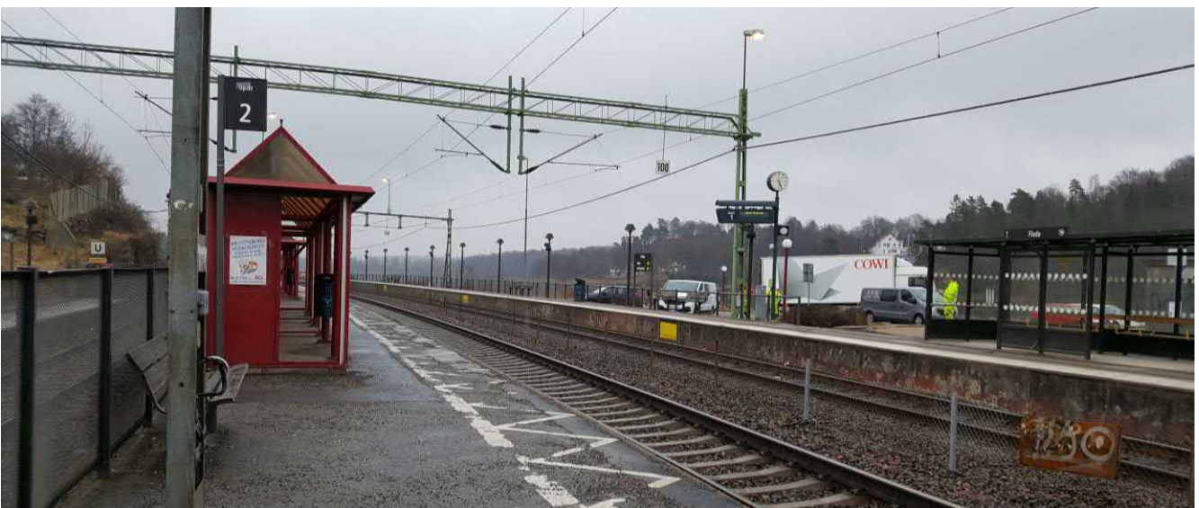
Stationsområdet i Floda. Befintlig mittplattform, som har brister beträffande tillgänglighet och trygghet, kommer att tas ur drift. Foto: COWI
