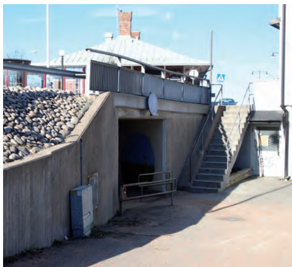
Befintlig tunnel under järnvägsområdet
