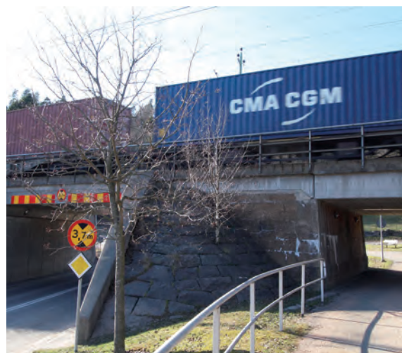
Järnvägsbro över Brovägen
