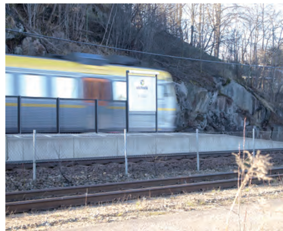
Eventuell bergschaktning öster om plattformarna
