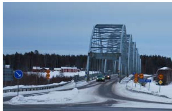
Bild 2.7 Gamla Gäddviksbron med smal avskild gång- och cykelväg..
