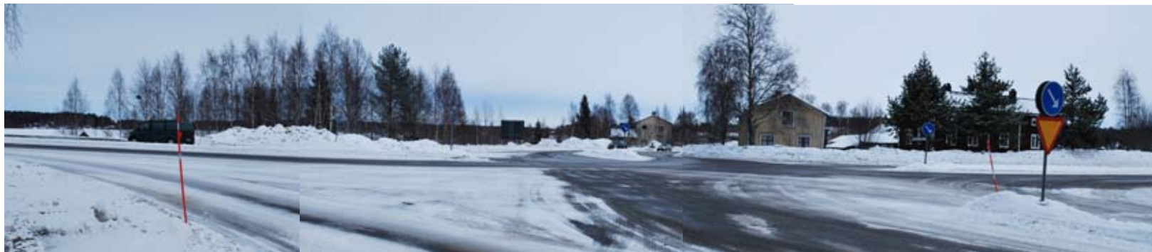
Bild 2.21 Stor vid korsning utan säkra passager för oskyddade trafikanter. Vy österut längs väg 616.
