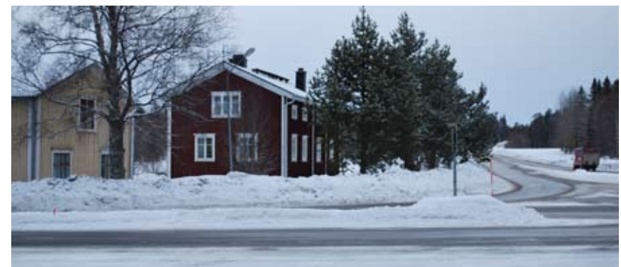
Bild 2.19 Bebyggelse nära korsningen, vy söderut längs väg 968.
