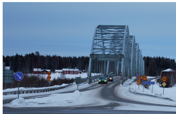
Bild 2.7 Gamla Gäddviksbron med smal avskiljd gång- och cykelväg.
