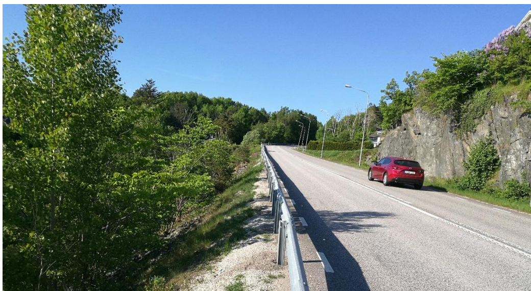
Figur 6. Längs väg 160 finns flera bergsskärningar på vägens östra sida, vy mot norr.
