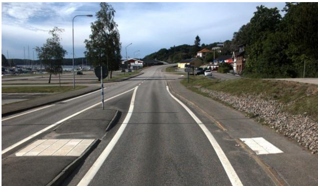
Figur 5. Aktuell sträcka börjar inne i Henån. Till vänster syns delar av parkeringsytan och småbåtshamnen. (Källa: Trafikverket, PMSV3 - information om belagda vägar)
