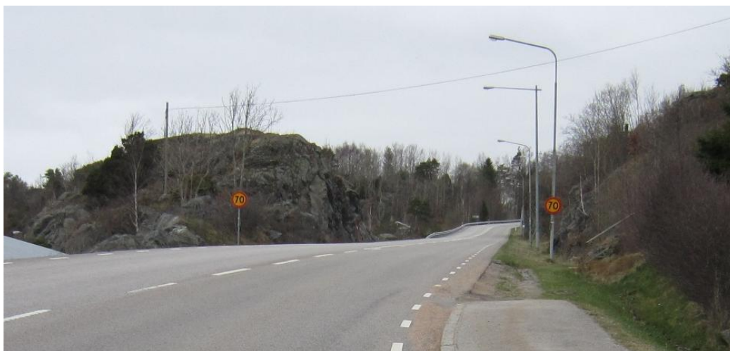
Figur 18. Slutet av befintlig gångbana på den östra sidan av väg 160. Bild tagen mot norr.
