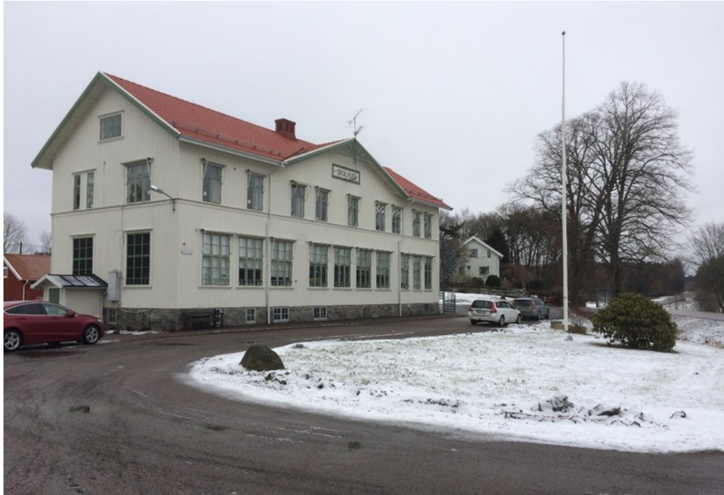
Figur 11. Den karaktäristiska äldre skolbyggnaden.
