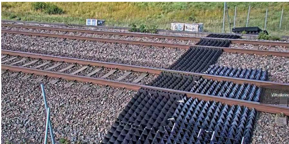
Figur 5.1.4:1 Exempel på pyramidmatta som anlagts utmed väg 42 i Koberg. Foto: Mattias Olsson.
