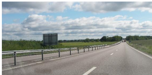
Figur 5. Exempelbilder på vajerräcke i mitten av vägen och rörräcke som sidoräcke.
