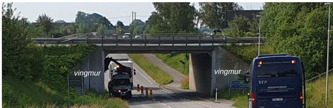
Figur 4. Foto på befintlig bro sett från norr
