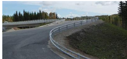
Figur 5. Exempelbilder på vajerräcke i mitten av vägen och rörräcke som sidoräcke.
