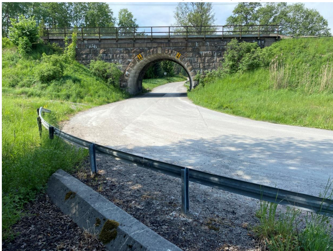
Figur 10. Den befintliga betongkulverten som leder Lövstaån under vägen genom järnvägsbron.
