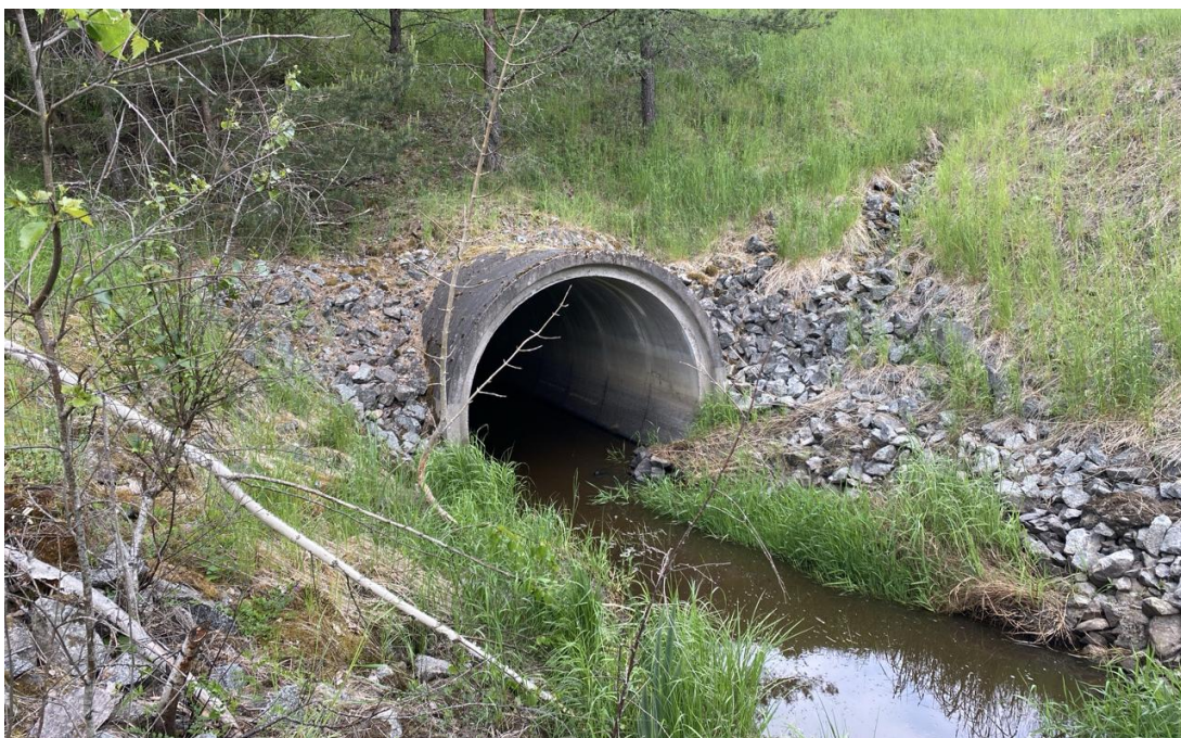
Figur 13. Erosionsskydd i Forsbyån i anslutning till befintlig järnväg. Nedströms järnvägen på västra sidan på den övre bilden och uppströms järnvägen på östra sidan på den nedre bilden.
