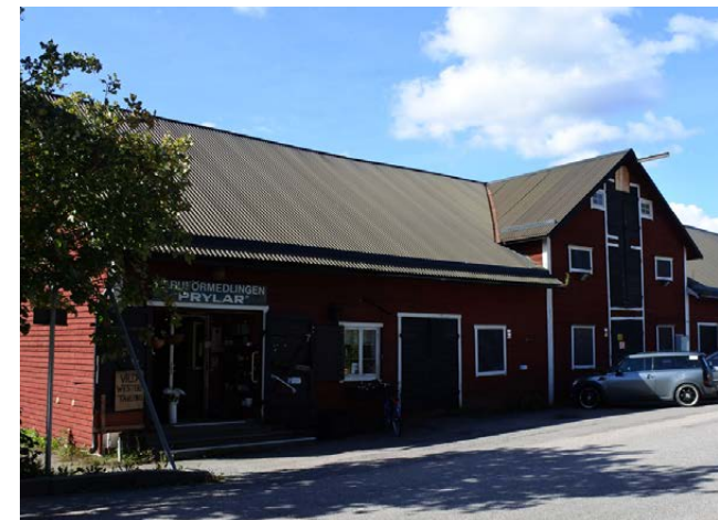
Figur 108. I magasinet i Knivsta på den östra sidan om järnvägen huserar idag flera lokala butiker. Byggnaden visar på Knivstas utveckling som stationssamhälle.
