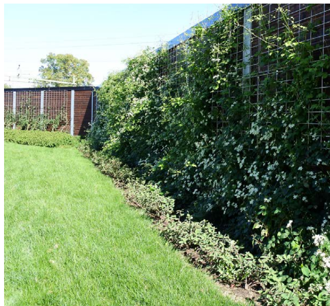
Figur 92. Bullerplank vid nybyggt bostadsområde i nordvästra Knivsta. Skärmarna minskar buller och det visuella intrycket av järnvägen.
