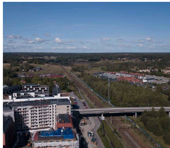
Figur 34. Gredelbyleden går över järnvägen på en bro norr om järnvägsstationen i Knivsta. Vy mot norra stadsgränsen och Trunsta. Foto: C.F. Möller Architects.
