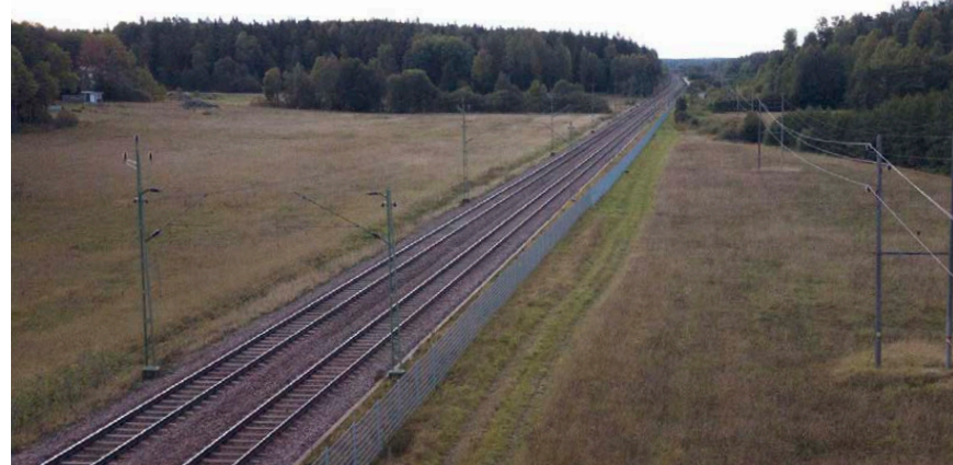
Figur 71. Flygbild mot söder över dalgången vid Nyboda där järnvägen är centrerad i det öppna landskapsrummet. Skogsområdet till höger i bild där det öppna rummet sluter sig har mycket höga naturvärden och utgör en nyckelbiotop med den fridlysta bombmurklan. Foto: C.F. Møller Architects.
