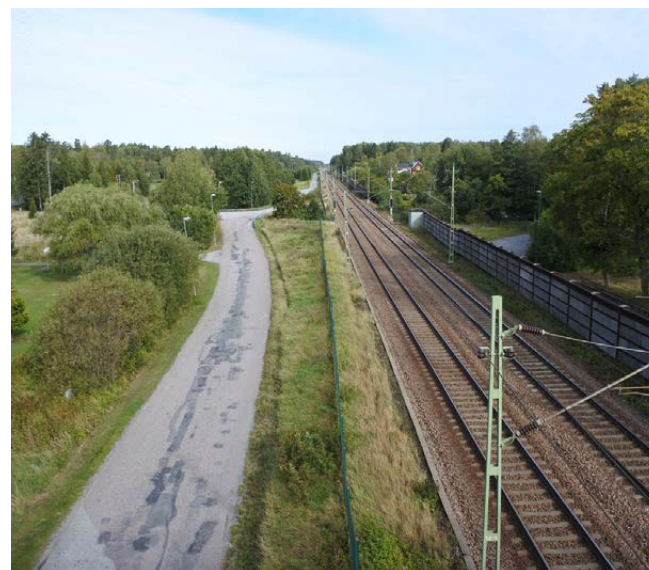
Figur 57. Järnvägen sedd mot norr från bron på Björkkälllevägen. Parallelt med järnvägen går Finnvretsvägen, till vänster om järnvägen i bild.
