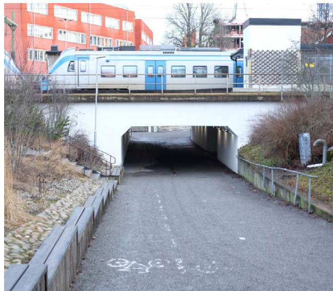
Figur 33. Gång- och cykeltunneln under järnvägen i Knivsta centrum, strax norr om plattformarna vid järnvägsstationen. Knivsta kommunhus i bakgrunden.
