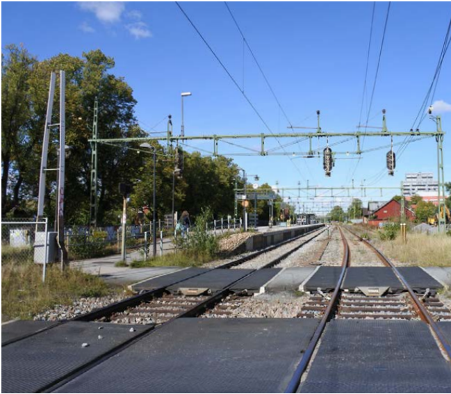
Figur 39. Den befintliga uppgången till plattformen i Knivsta från plankorsningen i söder.
