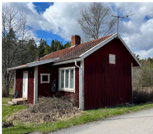
Figur 53. Banvaktstugan i Alsike som finns på den västra sidan om järnvägen.
