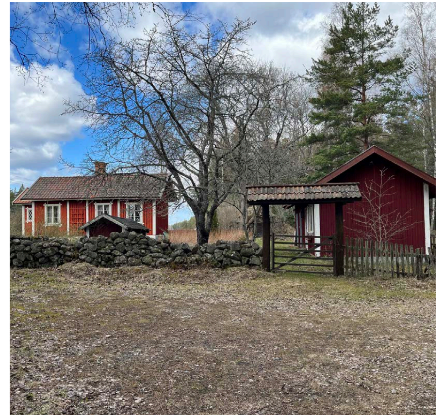
Figur 75. Söderby banvaktstuga är belägen på järnvägens östra sida. Den uppfördes 1866 och är en del av det kommunikationshistoriska arvet.
