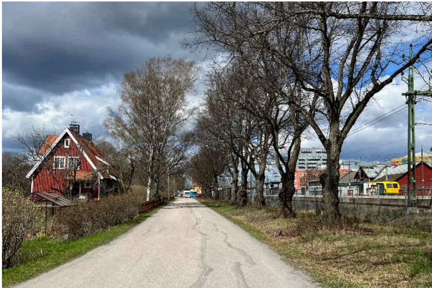
Figur 59. Vy från söder in på Stationsvägen på järnvägens västra sida. I bild syns allén längs järnvägen och SJs personalbostad från 1912.
