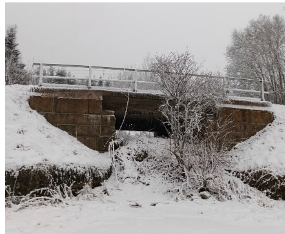
Figur 81. Vägport, som inte längre är i bruk, och den äldre banvallen i höjd med Forsby.
