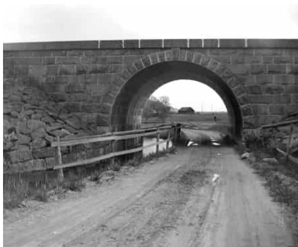
Figur 79. Järnvägsbro från 1866 och 1907 vid Knivsta sockencentrum. Senare har en överbyggnad och räcke tillkommit. Foto: Schagerström, August Fredrik, 1927, Upplandsmuseet.
