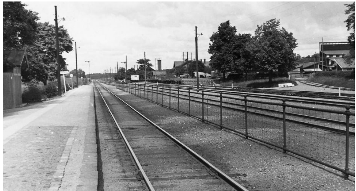
Figur 46. Del av Knivsta station, 1934, före elektrifiering av banan. Till höger i bild syns stickspåret till sågverket och tegelverket. Bildkälla: Järnvägmuseet
