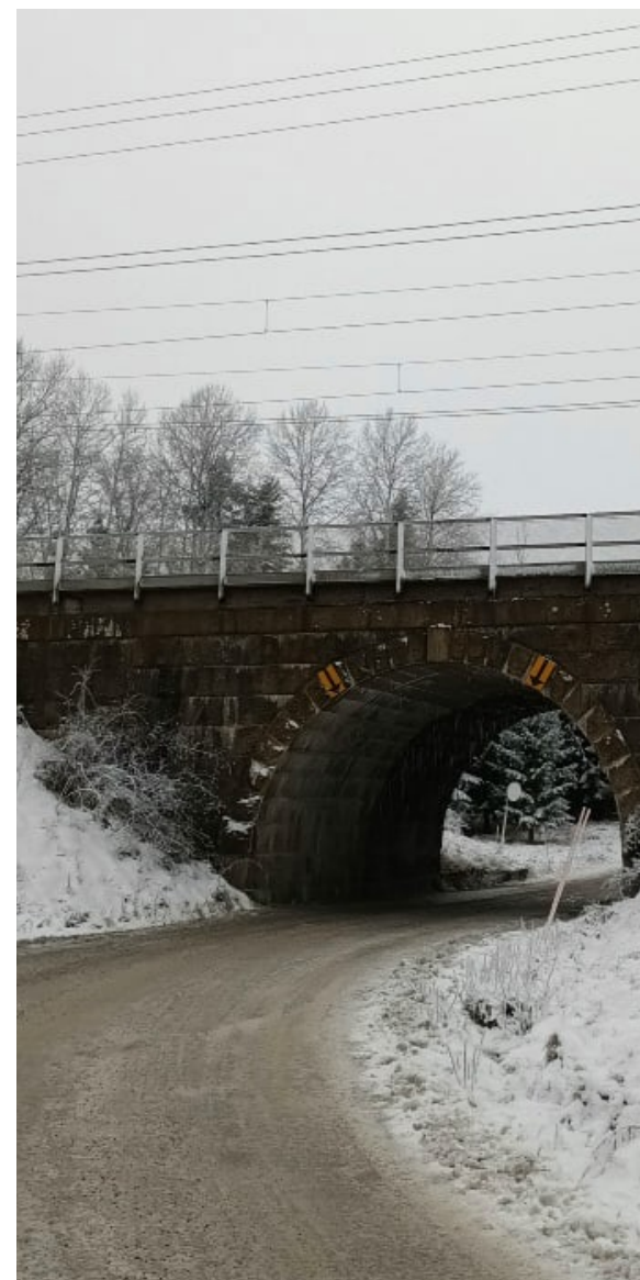
Figur 41. Äldre västräckning mellan Knivsta och Skottsila, som fått broöverbyggnad när järnvägen drogs genom landskapet.
