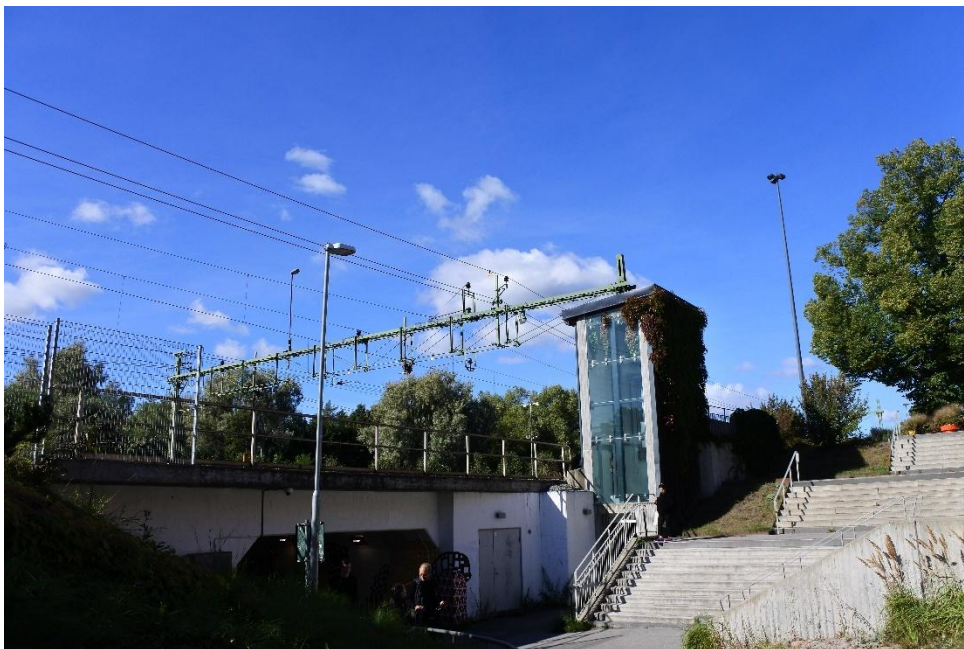
Figur 3. Den norra plattformanslutningen till Knivsta station nås idag via en gång- och cykeltunnel under järnvägen.
