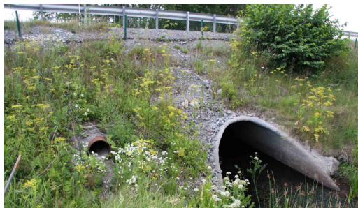
Befintlig uttermassage bredvid dagvattentrumma
