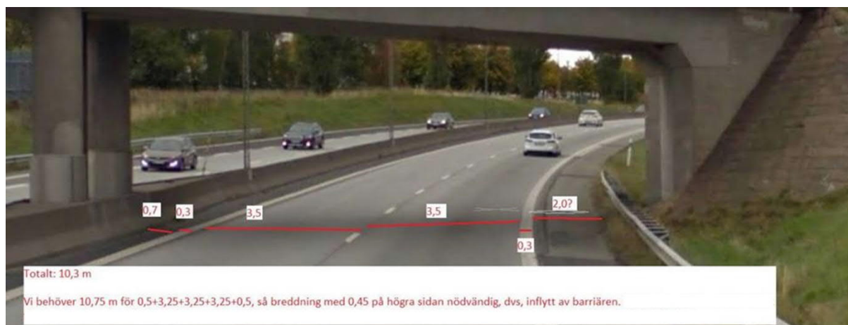
Figur 33: E4 under Jönköpingsbanan i västgående riktning. Grov inmätning (där jämförelse av bredderna även gjorts mot broskisser i BatMan) visar att man inom befintlig körbanebredd troligen saknar cirka 0,45 meter för att få plats. Det bör dock gå att flytta ut räcket på höger sida i bild. Avsikten med räcket är enligt expertis att skydda trafikanten (alltså inte att skydda bron mot påkörning), varför det är möjligt att fästa räcket i marken eller direkt mot eller i brofundamentet.
