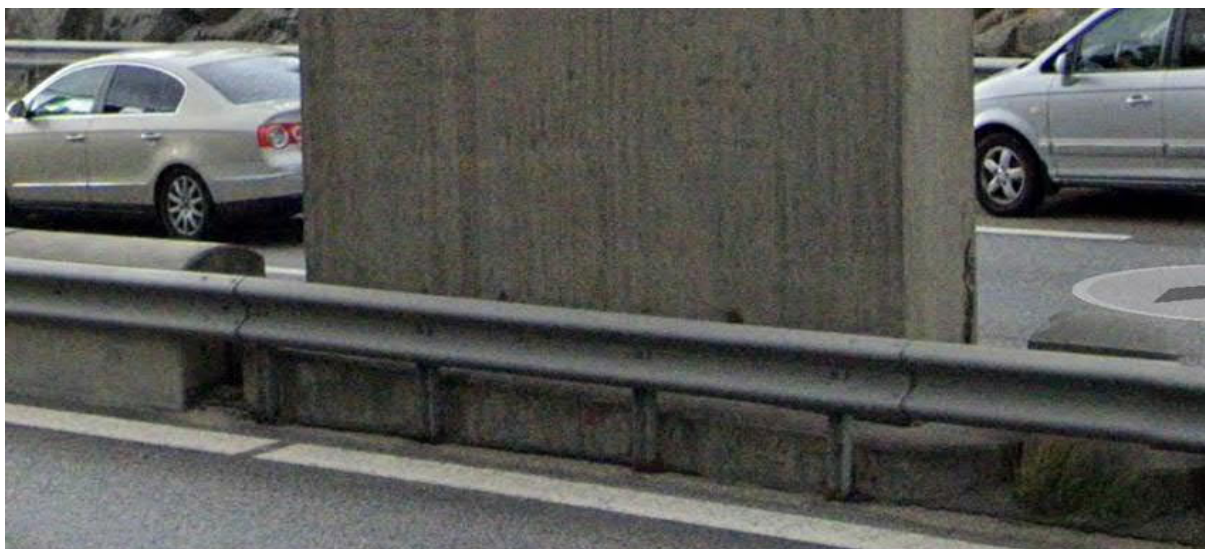
Figur 11: Föreslagen breddning för med sig att körfältet hamnar närmare mittstöden. Exempel på detta finns på E4 nordost om Södertälje. Här är dessutom hastighetsgränsen 100 km/h, dvs. högre än genom Jönköping.
