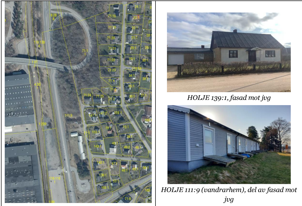
Figur 15. Översikt område vid km 41+700 till 42+100. Fasader mot järnväg för de bullerberörda byggnader där fasadriktvärdet överskrids samt för del av byggnad klassad som vandrarhem.
