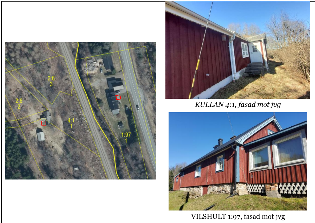
Figur 4. Översiktsbild KULLAN 4:1 och VILSHULT 1:97. Uteplatser markerade med rött.
