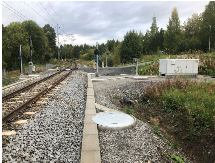
Anläggningen ger ett prydligt intryck
