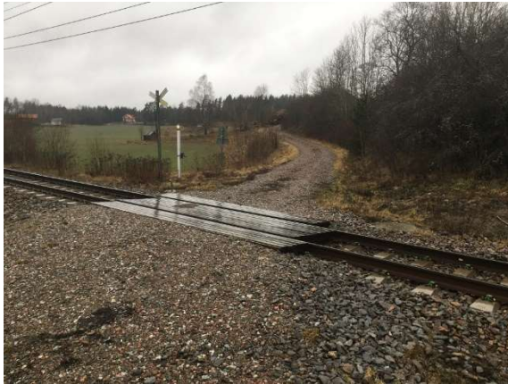
Plankorsningen Hammarby med Kryssmärke och E-signal (jämför omslagsbilden från samma position). Foto: Olle Mornell, 2019-03-08
