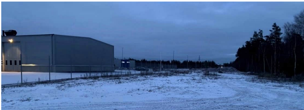
Figur 29 - Scantias byggnad i utredningsområdets sydöstra kant. (FP 12)
