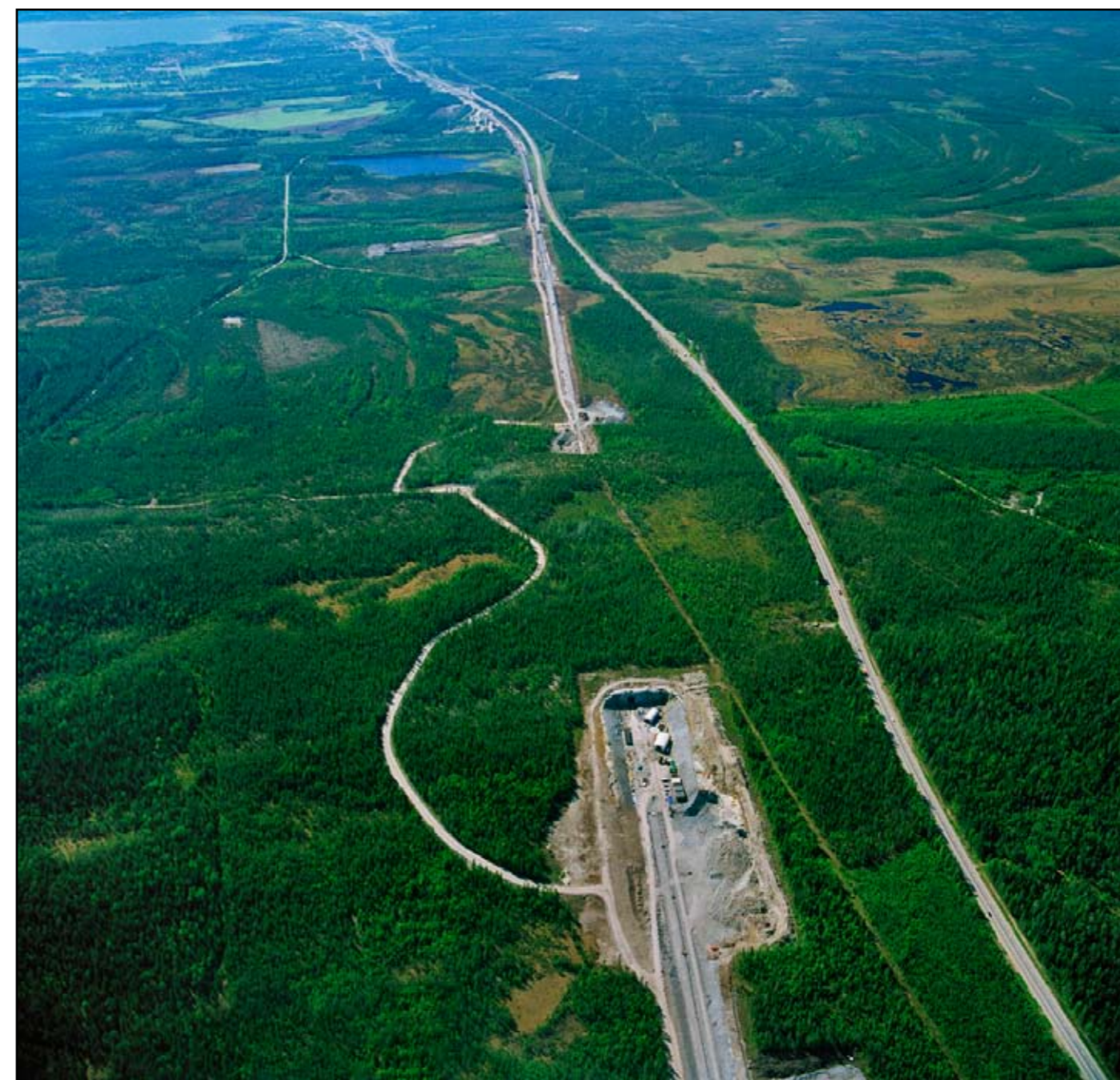
Planskild passage vid tunnel. Bilden är från Håknäskälen, Nordmaling där Botniabanan går i en kort tunnel och gör det möjligt att etablera en planskild passage över järnvägen. Notera att E4:an ändå måste passeras i plan.
