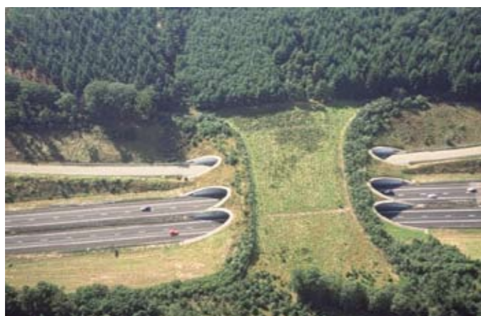
En ekodukt anläggs för att leda naturen över vägen eller järnvägen. Mänsklig trafik får inte förekomma på en ekodukt. Bilden föreställer en ekodukt i Nederländerna. Foto: Hans Bekker
