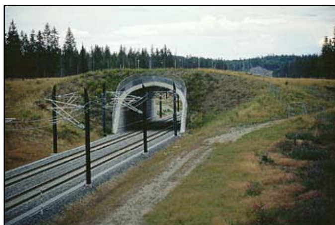
Ekodukt på Gardermobanen i Norge. Övergången som är 40 meter bred ligger i ett viktigt vandringsområde för älg. Foto: Statens vegvesen, Norge
