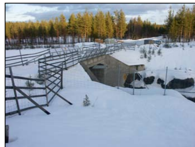
När järnvägen anläggs i en skärning kan det skapas förutsättningar för att anlägga en planskild passage. Bilden är från stambanan vid Kusfors där Mausjaure sameby regelbundet flyttar renarna över bron. Foto: Enetjärn Natur AB
