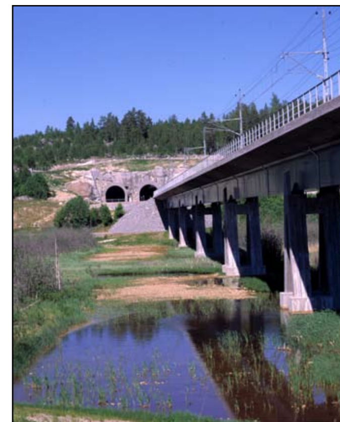
En s.k. landskapsbro skapar möjligheter för planskild passage under järnvägen. Bilden föreställer en järnvägsbro över våtmark vid Ålsjön, Söderhamn. Foto: Thomas Fahlander
