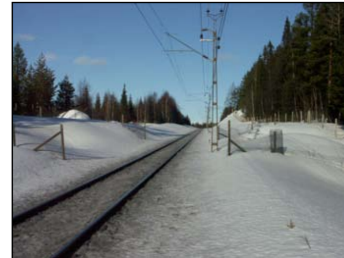
Det hoprullade stängslet till höger i bild rullas ut tvärs över spåret innan renarna ska passera och hindrar dem från att smita längs järnvägen. Bilden föreställer passagen vid Polak-vägen, Stor-Blåliden inom Östra Kikkejaures betesmarker. Foto: Enetjärn Natur AB
