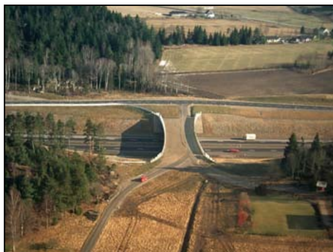
En vägbro anpassad för djur en s.k. viltbro. Bilden är från E6:an vid Rytingen norr om Uddevalla. Foto: Mattias Olsson
