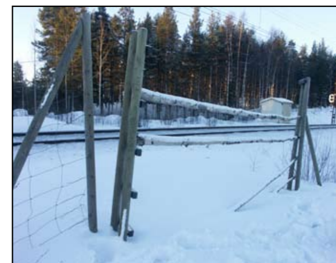
En grind vid banvallen söder om Ekträsk där eftersatt underhåll gör att renarna snart kan leta sig in på spåret. Slanorna är helt enkelt för korta, dessutom gjorda i obarkad björk som snabbt ruttar. Foto: Enetjärn Natur AB
