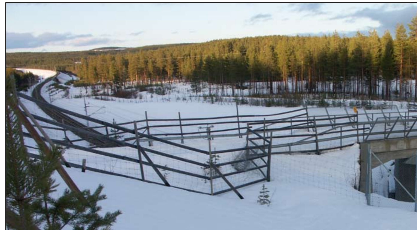
En möjlig skadelindrande åtgärd som kan vidtas utmed den nya järnvägen är planskilda passager för renarna. Bilden visar en sådan passage utmed stambanan vid Kusfors som regelbundet används av Mausjaure sameby. Foto: Enetjärn Natur AB
