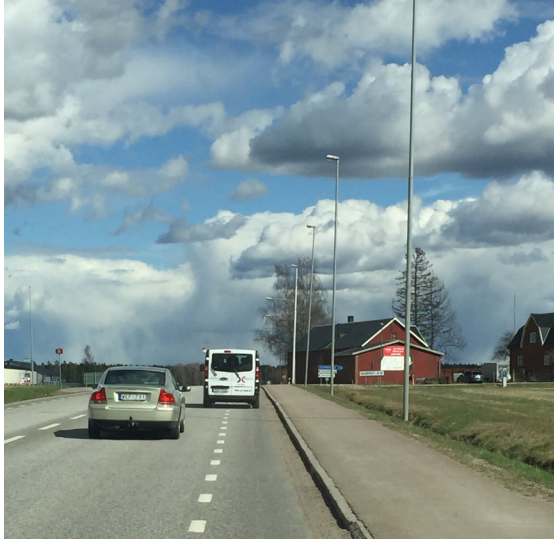
Figur 3.2 Väg 56 mot öster, strax öster om Sala tätort.
