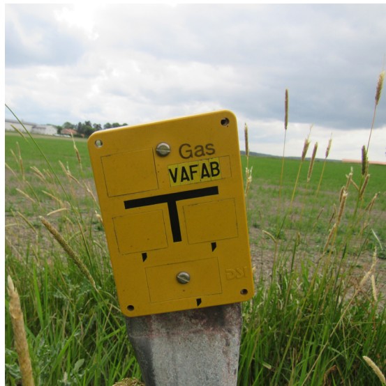
Figur 3.5 Utmarkerad gasledning invid väg 56.
