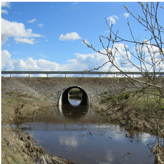
Figur 3.6 Röbro under väg 56.
