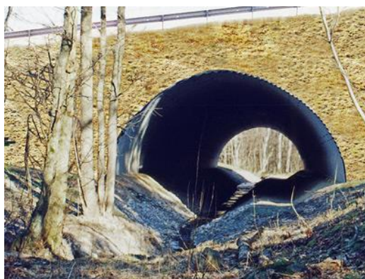
Figur 5.4.3:2 Exempel på rörbro
