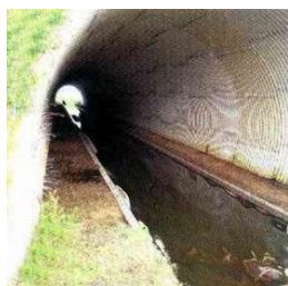
Bild 5.4.1:3 Exempel småviltspassage i rörbro
