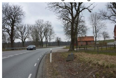
Bild 4.2.3.5 Befintlig väg genom Assmåsa
