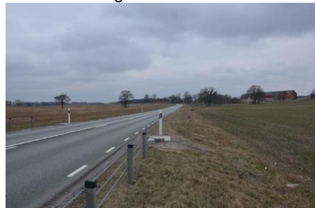
Bild 4.2.3.3 Flack väg mot Assmåsa gård
