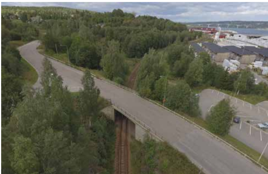
Figur 3.2:1 Sjöfartsvägen korsar befintligt Tunadalsspår på bro. Till höger i bilden syns Tunadals sågverk och i fonden Alnöbron.
