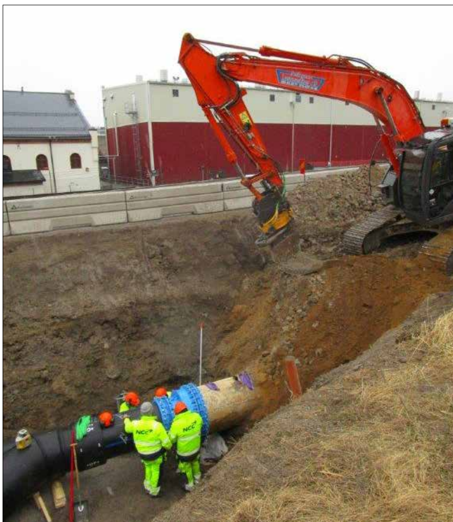
Figur 10.2:1 Förberedande arbete för Tunadalsspårets upprustning när SCA-tuben läggs om, april 2017.
