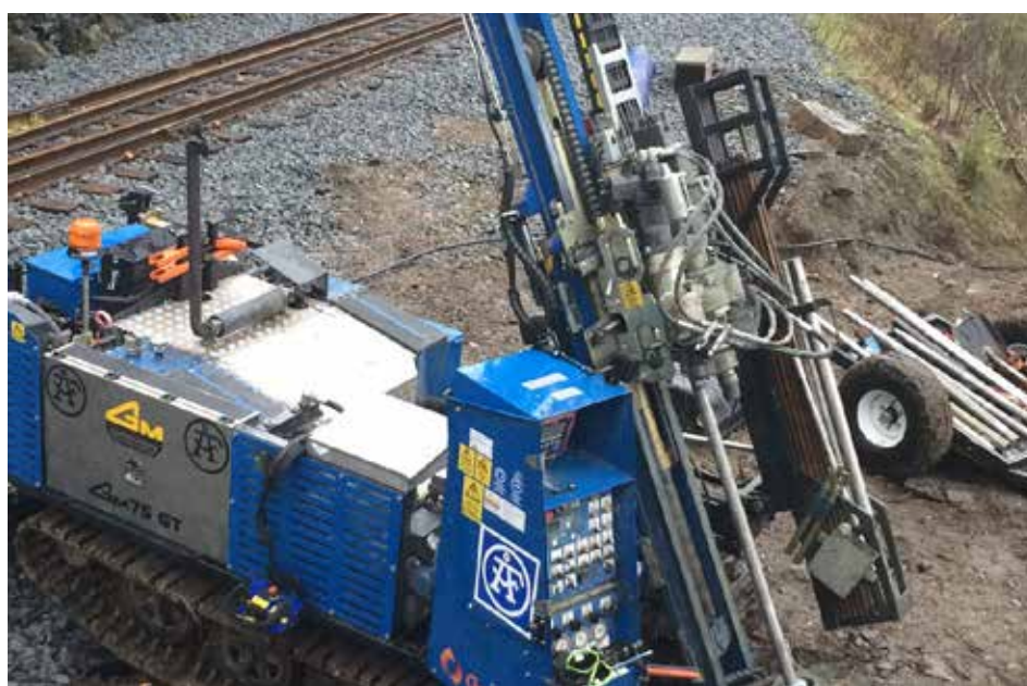
Figur 4.5:22 Jordprovtagning med geoteknisk börbandvagn
