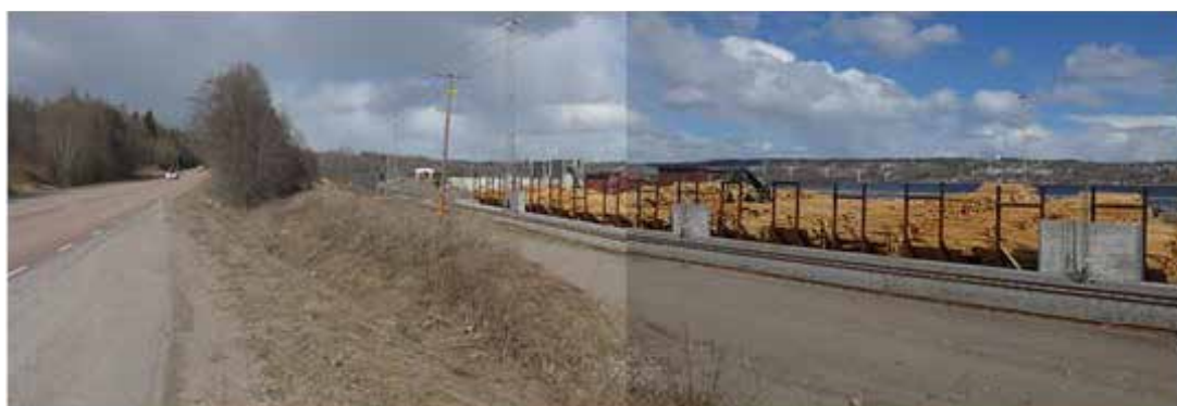
Figur 4.5:31 Befintlig järnväg och Tunadals sågverk, upplag av timmer.
