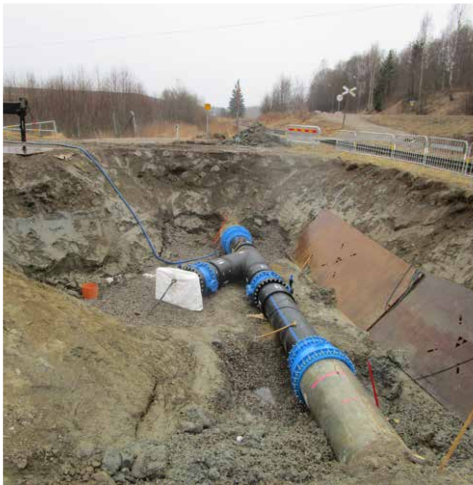
Figur 2:1:1 I samband med ett kortvarigt driftstopp för SCA Ortviken våren 2017 genomfördes omläggning av verksamhetens vattenintag i de delar som påverkas av Tunadalsspårets upprustning.
