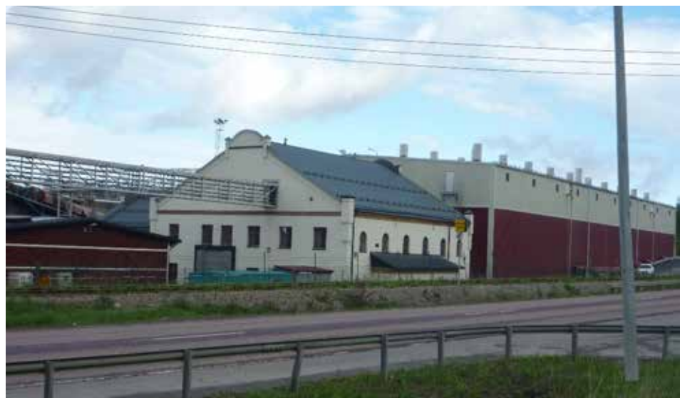
Figur 4.5:14 Det gamla vitputsade pannhuset ingår fortfarande i Tunadals industrimiljö.
