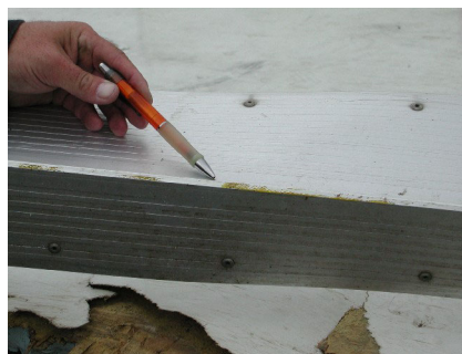
Släpet (totalt demolerat).
