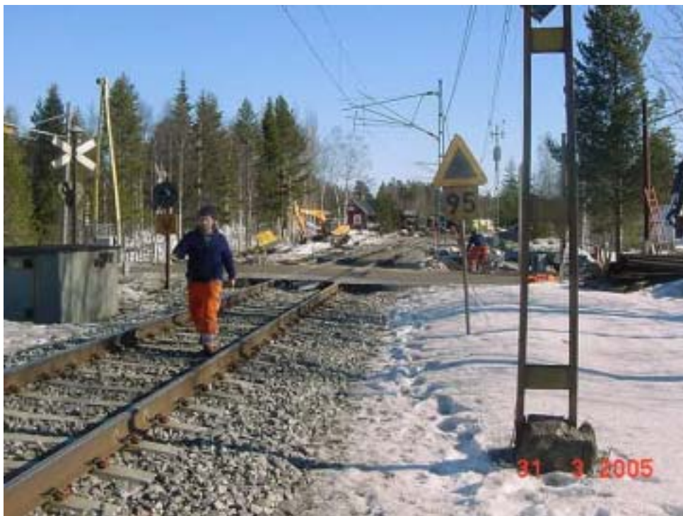
Tågets färdväg in i Plankorsningen
