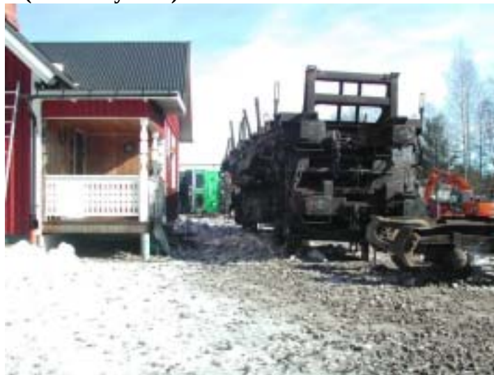
Fastighet intill spåret, som fick skador (buskar, staket, målarfärg mm)
