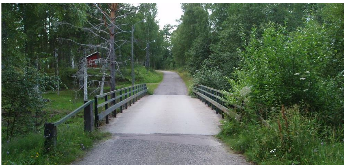
Bild 7 Bro 40-1860-1 över Uvan vid Kanalen
