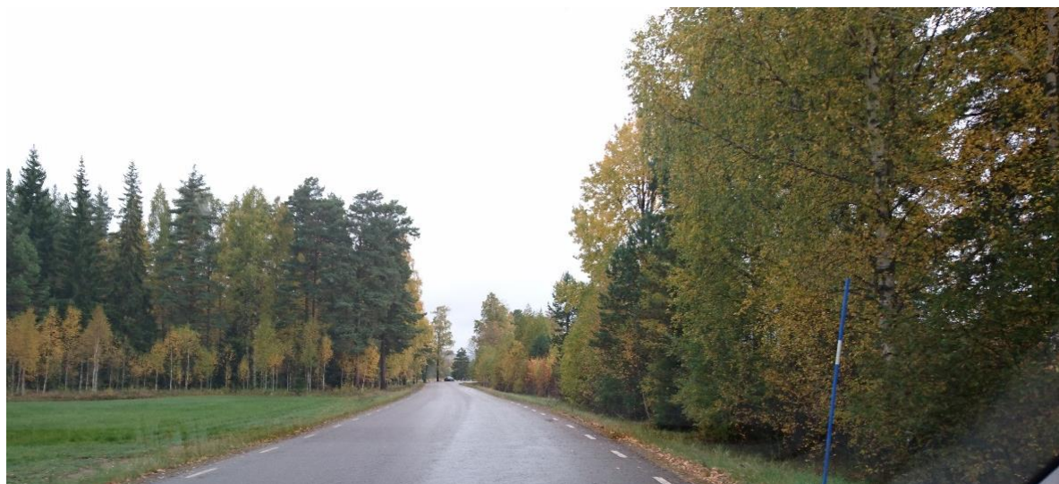
Bild 11 Väg 843 söder om bron
