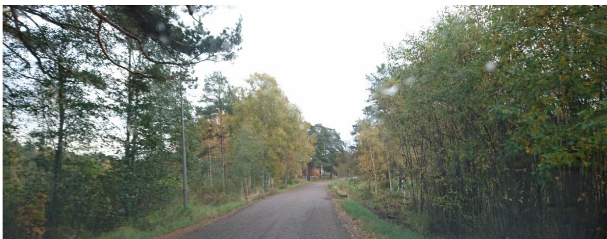
Bild 15 Väg 27072.1 öster om Gustavsfors samhälle vid vägtrumma
