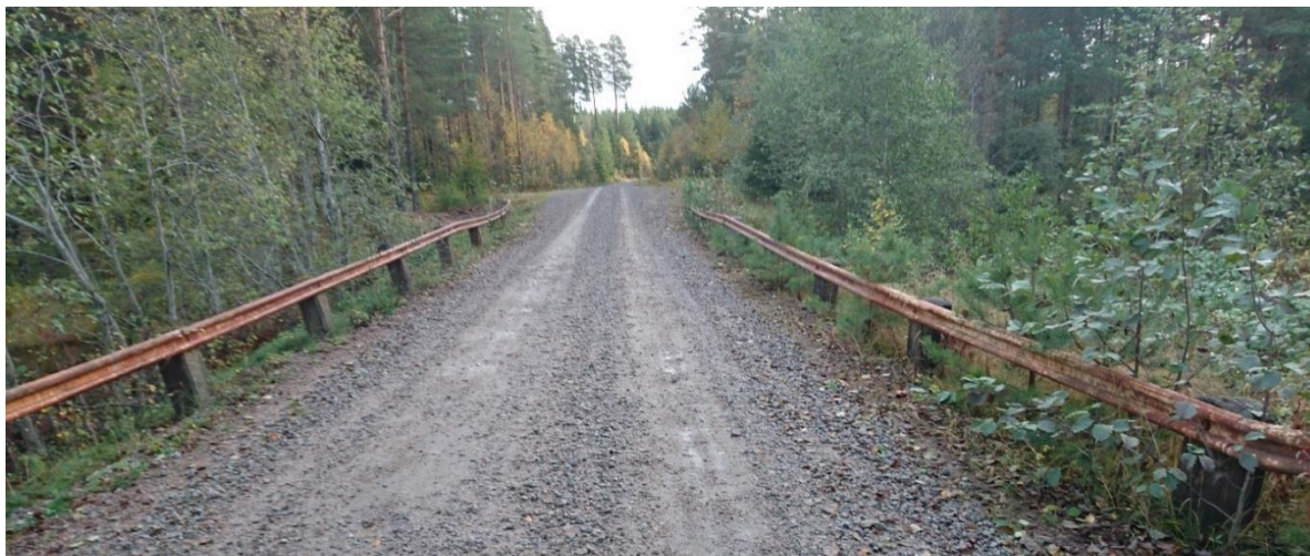
Bild 14 Väg 27072.1 öster om Gustavsfors samhälle vid vägtrumma
