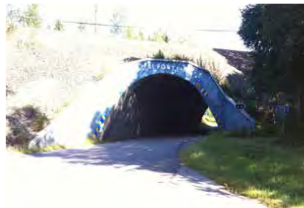
Bild 13. "Dalporten". Befintlig vägport under järnvägen
