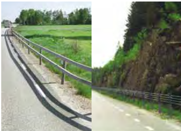
Rörräcken och stållineräcken är exempel på räkestyper som båda har god genomsikt. Källa: Vägen, en bok om vägarkitektur.
