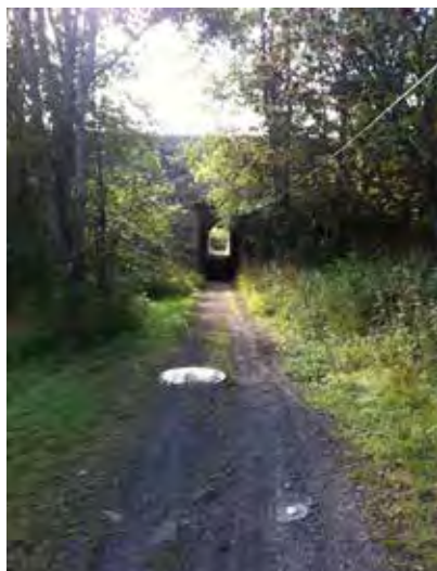
Bild 12. Befintlig gångtunnel under järnvägsbanken.
