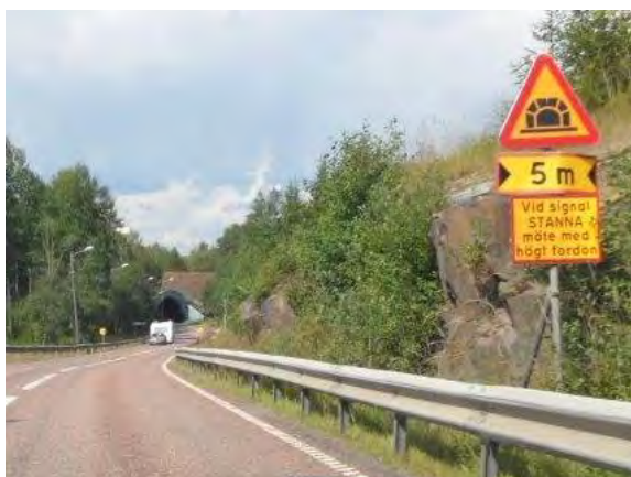
Figur 7 Signalreglering vid Dalporten, väg 50 riktning norrut.
