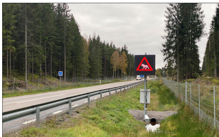
Figur 10. Viltvarningssystem med blinkande ljus vid Faunapassage i plan. Bilden visar en meddelandeskylt.
