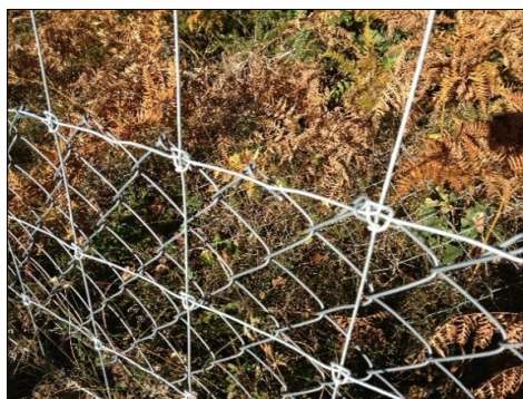
Figur 3. Faunastängsel är mer finmaskigt än viltstängsel och stänger därför även ute småvilt från vägbanan.
