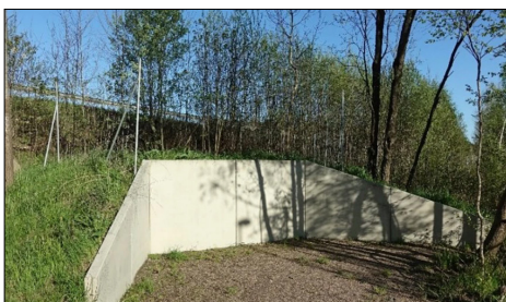
Figur 4. Viltuthoppet är en konstruktion som gör det möjligt för djur att ta sig ut i naturen igen efter att de har kommit in på fel sida viltstängslet. Uthoppets höjd blir 1,5 meter och är anpassat till landskapet och viltstängslet.
