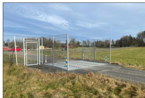
Figur 5. Färisten kan bestå av ett gallerssystem som framför allt klövdjur undviker att gå över. De används vid stängselöppningar där en enskild väg ansluter till en stängslad väg.
