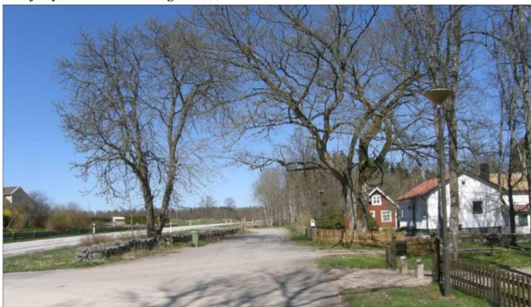
Figur 20: Skörje by norr ut. Den gamla landsvägen ligger parallellt med befintlig väg 27. Källa: Wallin, 2015a.
