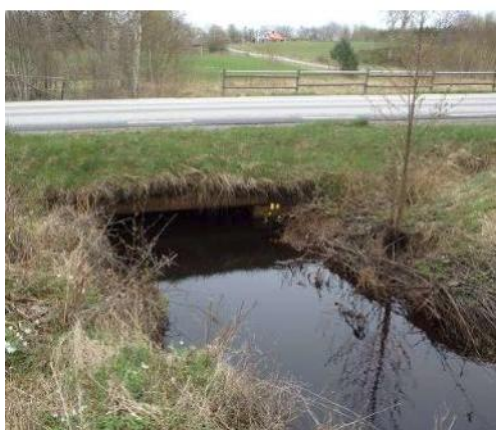
Figur 33: Störtbäckens genomföring under befintlig väg 27. Sydvästra sidan, Västra Hult syns i bakgrunden.
