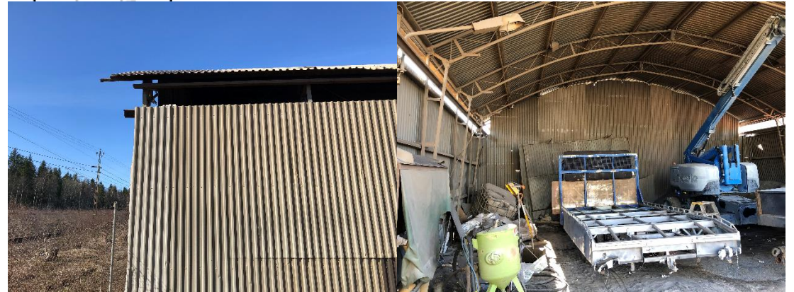
Bilden till vänster visar byggnaden från sidan med järnvägen till vänster medan bilden till höger visar hur insidan ser ut. Den borte väggen är riktad mot järnvägen. Bilderna togs under ett platsbesök.
