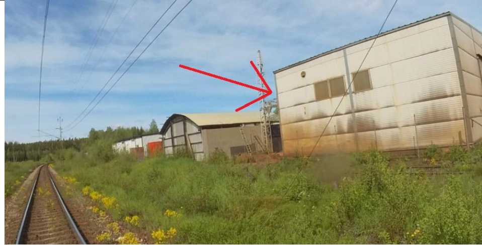
Den första bilden visar byggnaden från sidan med järnvägen till vänster och den andra bilden visar byggnadens relation till befintlig bana. Bilderna togs under ett platsbesök.
