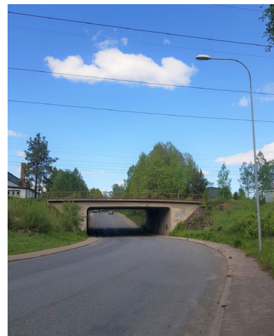
Figur 5 Viadukt vid Lastgatan.
