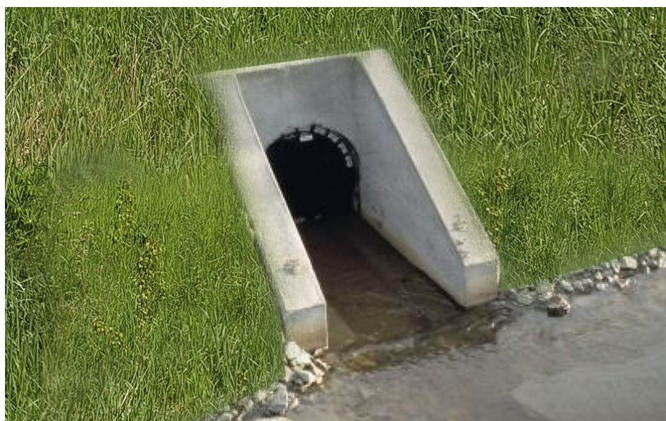
Figur 14 Exempel på trumöga med ände som följer släntlutning.
