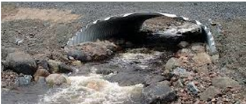
Figur 15 Exempel på faunapassage för medelstora däggdjur med torrlagd strandpassage.
