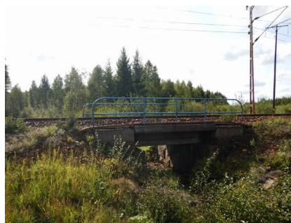
Figur 8 Befintlig bro över Kvarnbäcken sett från sidan av befintlig järnväg.
