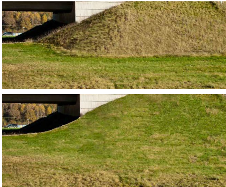
Figur 11 Exempel på slänt med eller utan avrundning. Foto Trafikverket (Vägbilder).
