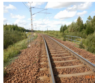
Figur 9 Befintlig bro över Kvarnbäcken sett från befintlig järnväg.
