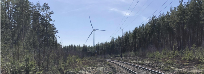
Figur 4 Foto från sträckan, sett i sydlig riktning.
