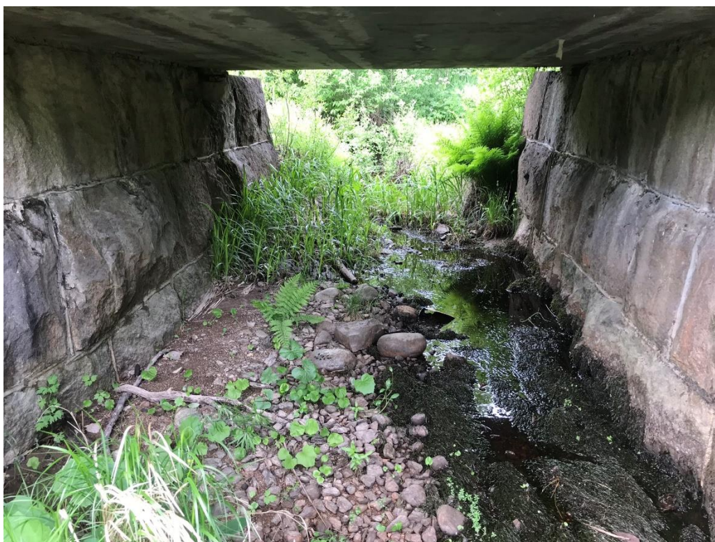
Figur 7. Passage av vattendraget, bron har ett innermått på bredd på 2,5 m och höjd på 1,5 m
