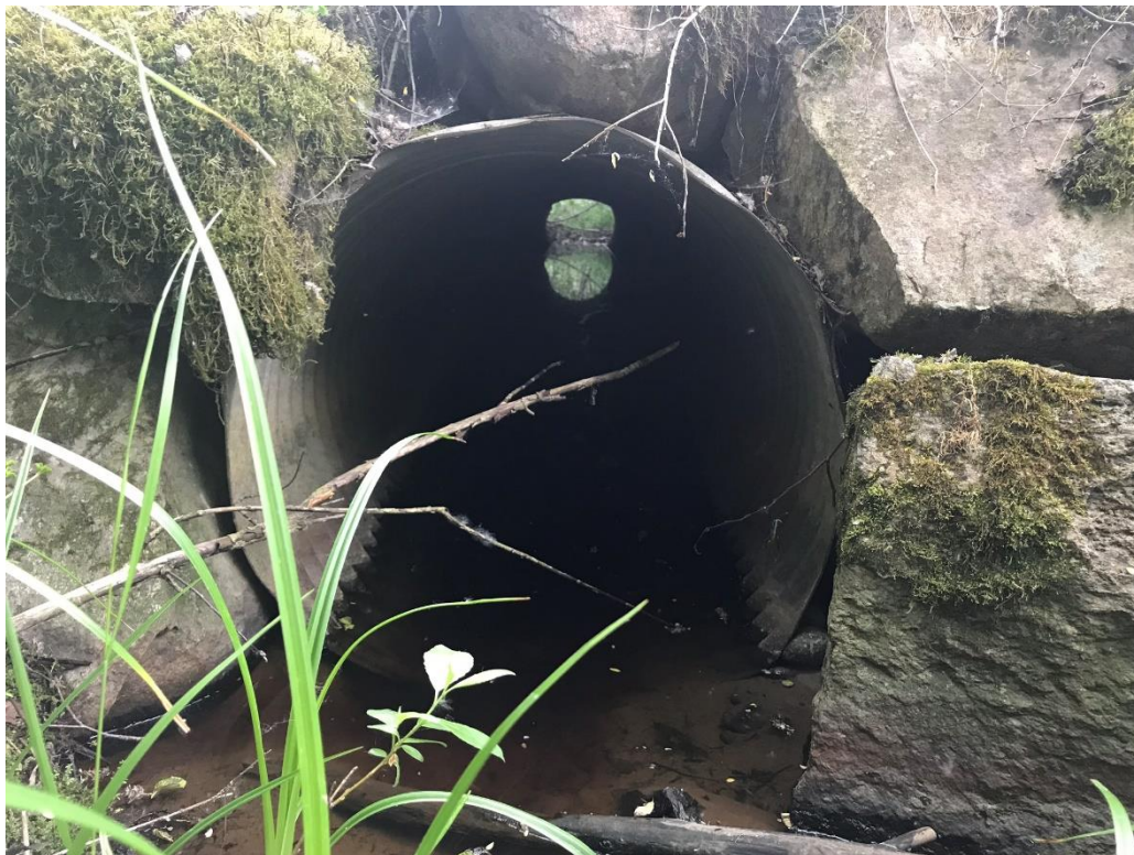
Figur 4. Trumma vid passage av skogsbilväg. Diameter 800 mm.
