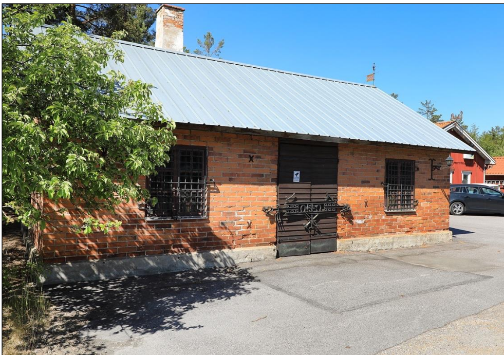
Figur 24. Smedjan på fastigheten 1:19 byggdes cirka 1900 och användes in på 1980-talet.
