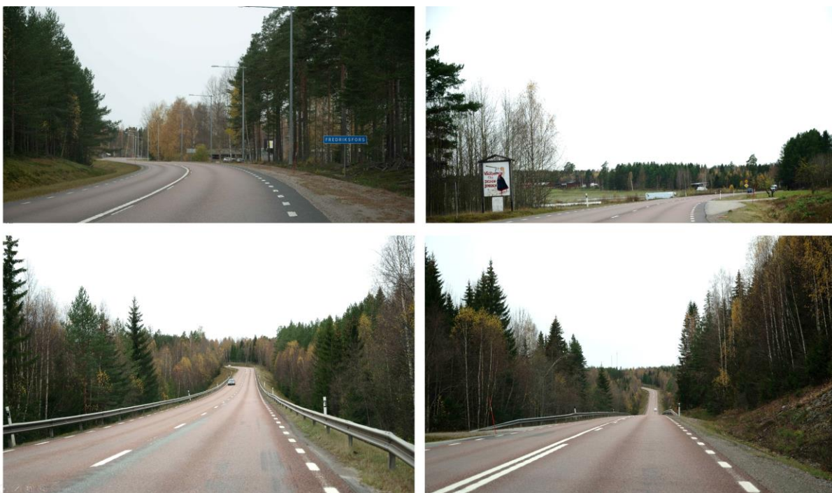
Figur 4.1 - Överst till vänster: Entré mot Fredriksfors från öster med belysning och hastighetsbegränsning 70 km/h. Överst till höger: Öster om rampen som ansluter mot bro över Dellenbanan finns jordbruksmark. Dellenbygden mot väster. Nedre vänstra och högra bilden: Skogsmarken dominerar i utredningsområdets östra del. Vägen har en varierande profil med skärningar och slänter.
