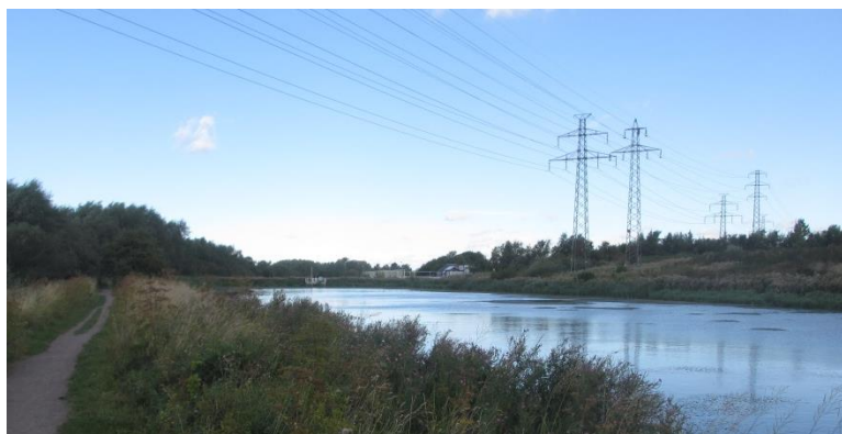
Figur 31. Vid Källby avloppsreningsverk finns dammar som ingår i vattenskyddsområde.
