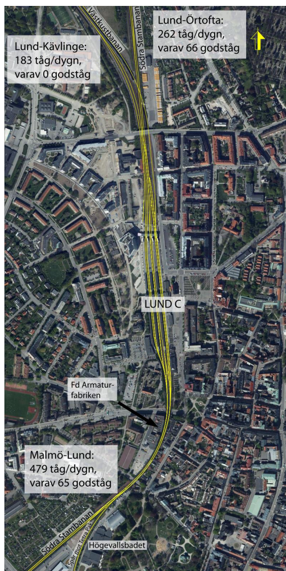
Figur 9. Södra Stambanans och Väst kustbanans anslutning till Lund C samt genomsnittlig trafik under ett dygn 2015. Vid Högevallsbadet finns stickspår mot Tetra Pak.
