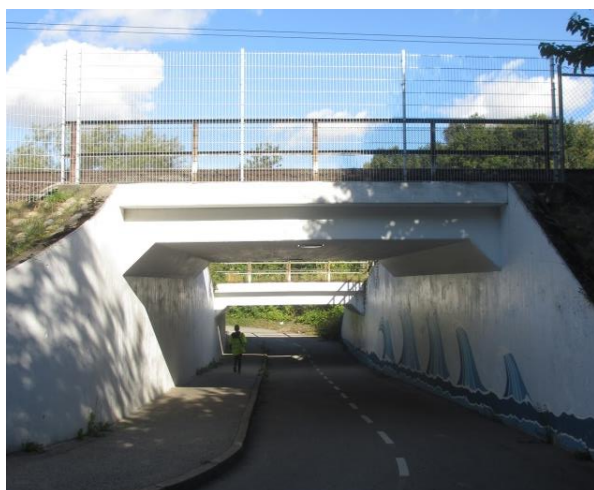
Figur 7. Broar över gång- och cykelväg vid Nordanväg/Maskinvägen.
