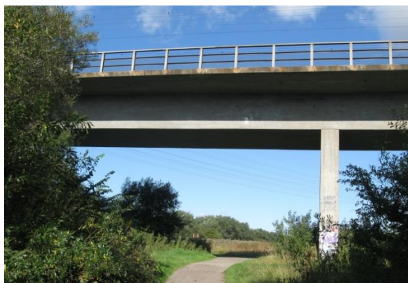
Figur 6. Bro över gång- och cykelväg vid Höje å.
