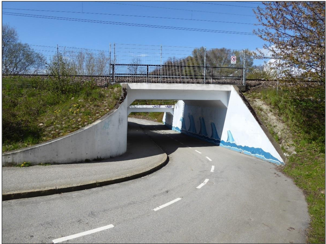
Figur 5. Gång- och cykeltunneln mellan Nordanväg och Maskinvägen.
