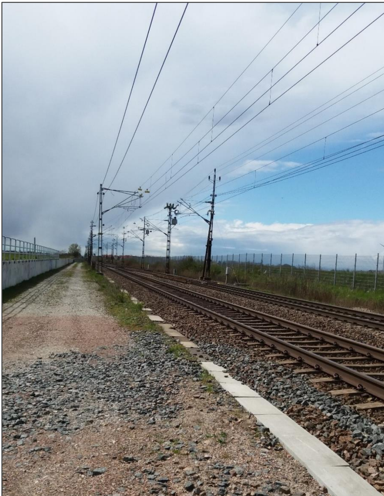
Figur 2. Södra stambanan söder om väg 108.
