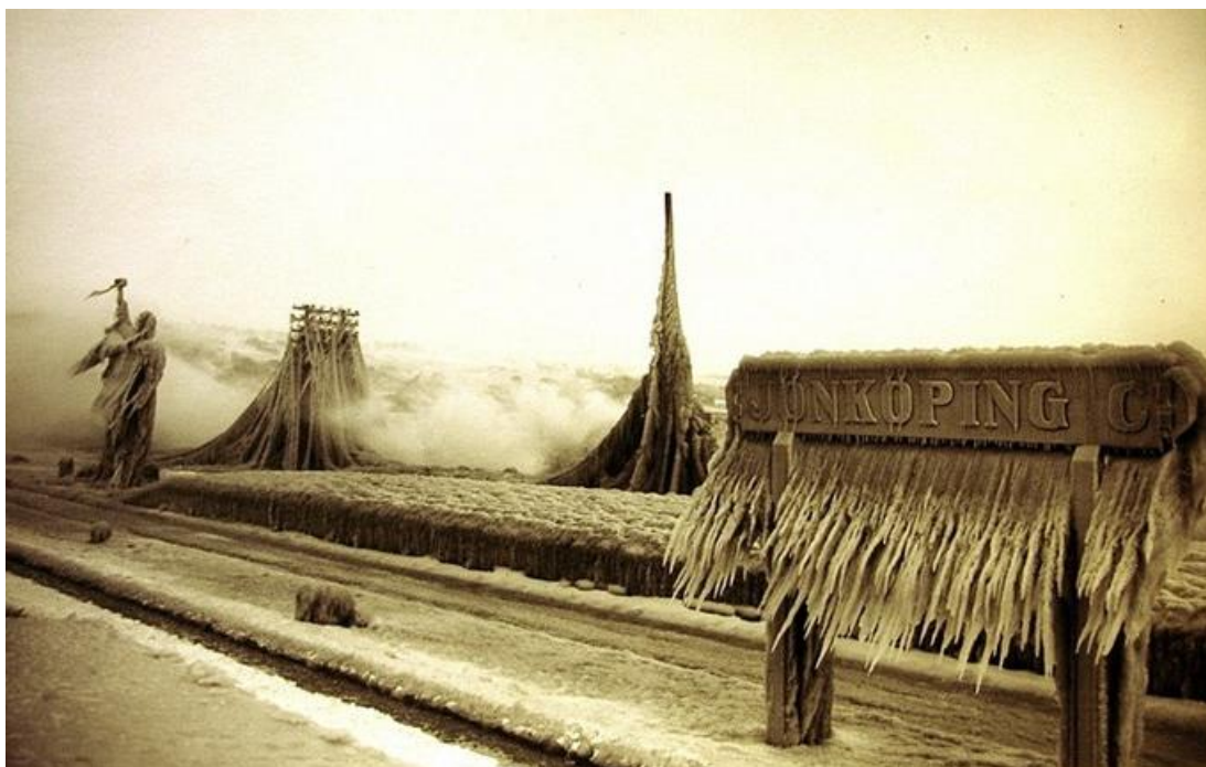
Figur 20. Bild från Jönköpings stationsområde efter att vatten från Vättern blåst in och frusit på anläggningen i januari 1929. Källa: Foto: Emil Eriksson, Järnvägmuseets arkiv/SMTM. PDM.
