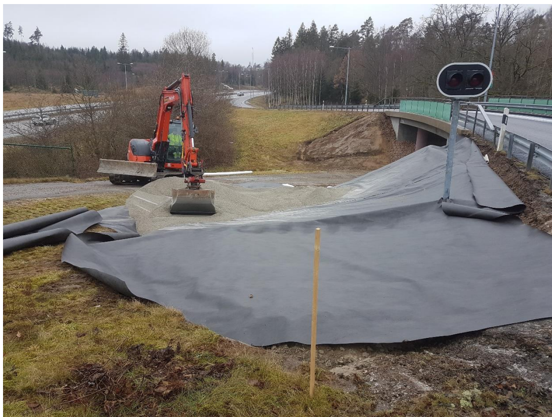
Figur 32. Det är vanligt att parkslide förekommer vid brofundament. Genom att använda en duk har mängden massor som grävs ur minimerats. Dock finns risk för genomträngning av rötter vid ändar, skarvar och stolpgenomföringar. Väg E6, Lerbomotet utanför Uddevalla. 2019. Foto: Svevia.
