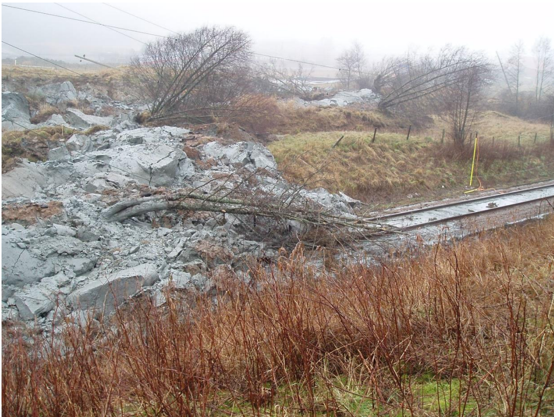
Figur 24. Lerrmassor som trycks upp på Bohusbanan i samband med skredet 2006 vid Småröd, Västra Götalands län. Foto: Trafikverket.
